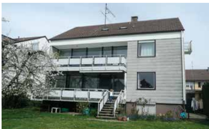
Wohnhaus in Stuttgart-Möhringen vor und nach der energetischen Sanierung. Der Endenergiebedarf konnte um 47 Prozent reduziert werden (Fotos: Energieberatungszentrum Stuttgart e.V. und Kraft Architekten, Stuttgart)
