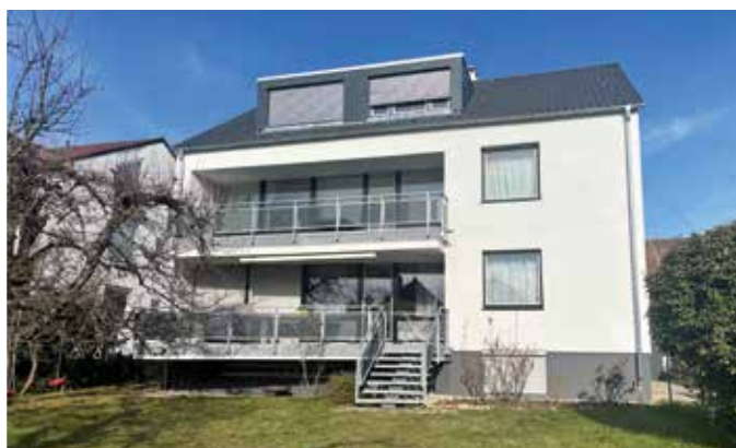
Wohnhaus in Stuttgart-Möhringen vor und nach der energetischen Sanierung. Der Endenergiebedarf konnte um 47 Prozent reduziert werden (Fotos: Energieberatungszentrum Stuttgart e.V. und Kraft Architekten, Stuttgart)
