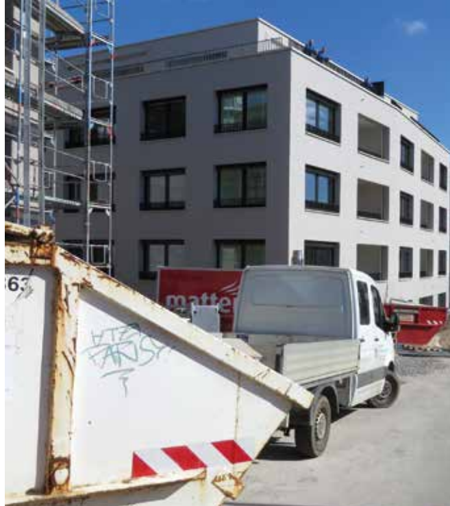
Eine der derzeit größten Baustellen in Stuttgart-Ost: Neubau von fünf Mehrfamilienhäusern mit 94 Mietwohnungen auf dem ehemaligen Diakonie-Areal (Foto: Lutz Deutz).
