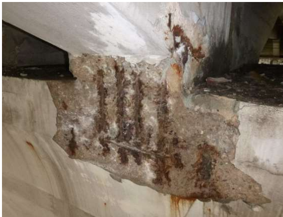
Schadensbilder Betonabplatzungen und korrodierte Bewehrung
