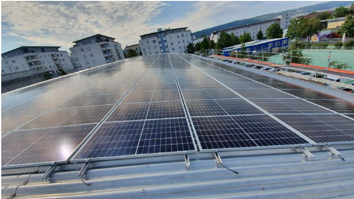
Bild 35 Bau der Photovoltaikanlage auf der Turnhalle der Maria-Montessori-Schule
