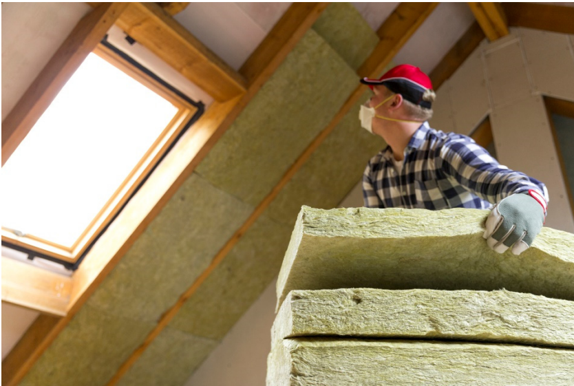
Bild 23 Dämmung eines Daches ©artursfoto@istockphoto.com
