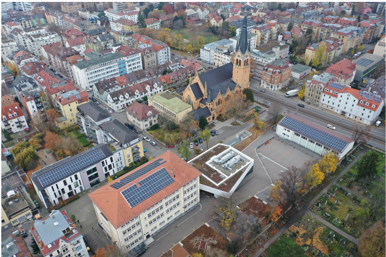
Bild 34 Photovoltaikanlagen auf den Gebäuden der Martin-Luther-Grundschule (Stadtwerke Stuttgart)
