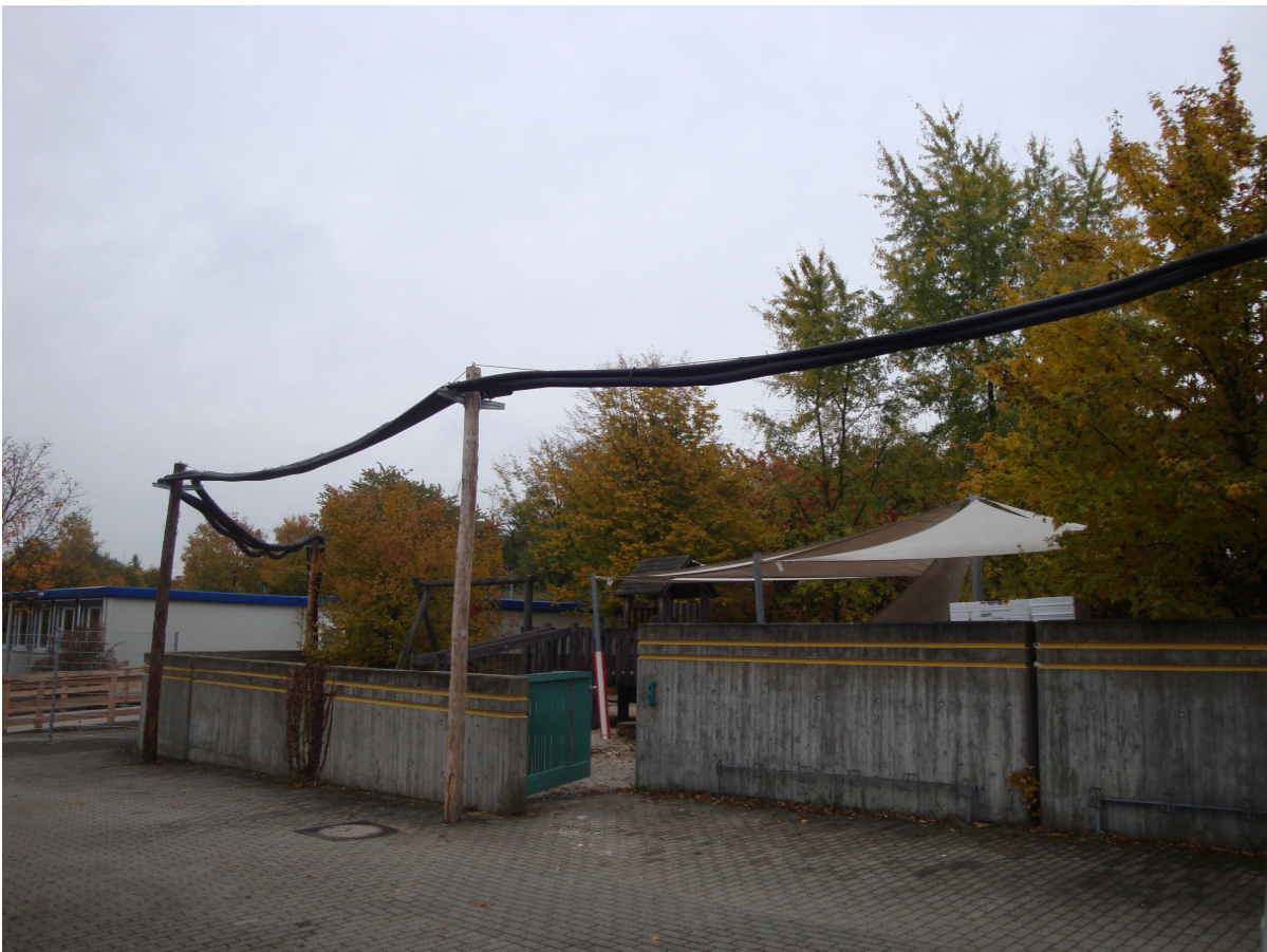
Leitungsanbindung -> Medien von Turnhalle aus oberirdisch geführt
