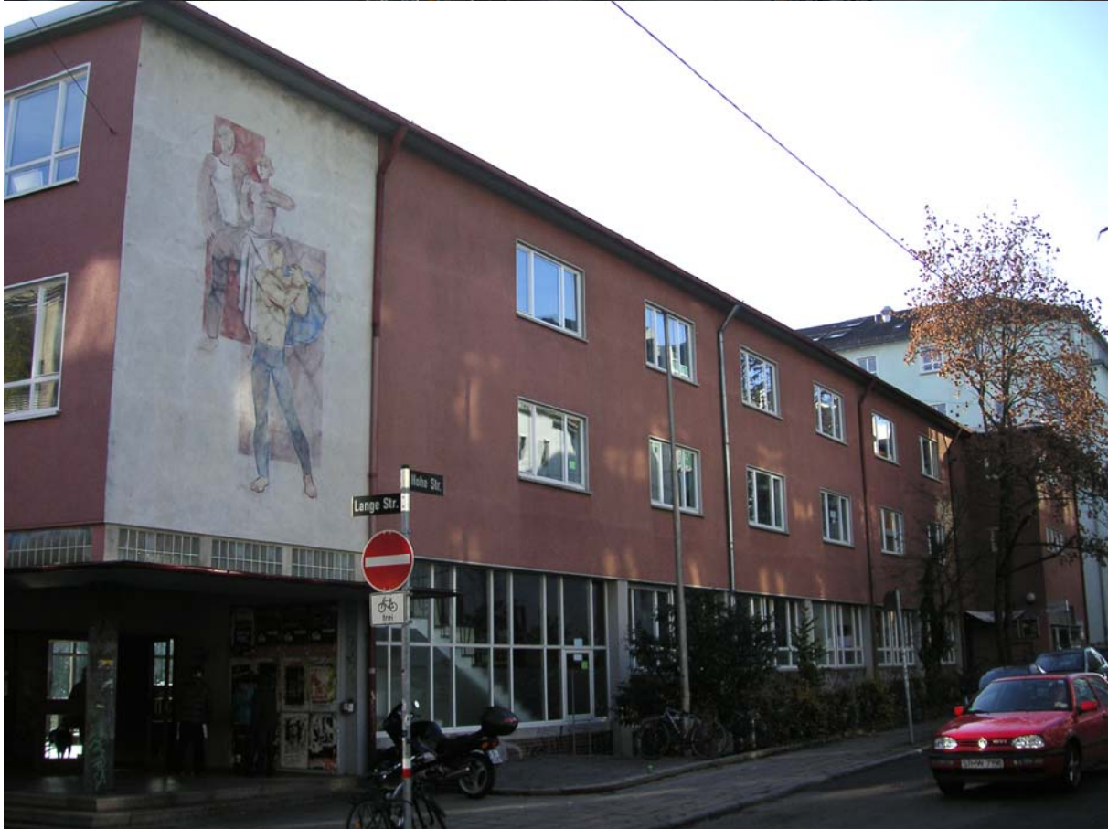
Fassaden/ Eingangsbereich Lange Straße/ Hohe Straße
