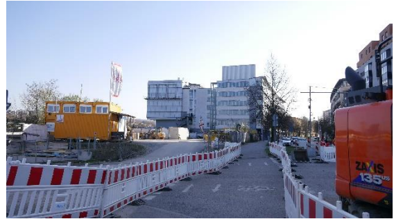
Abbildung 4: Blick auf den Gebäudekomplex Rosensteinstraße 22+20 von Norden
