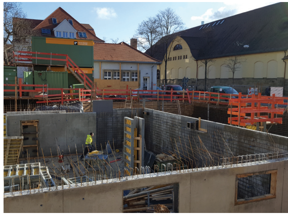
Baustelle Mehrgenerationenhaus im März 2017
