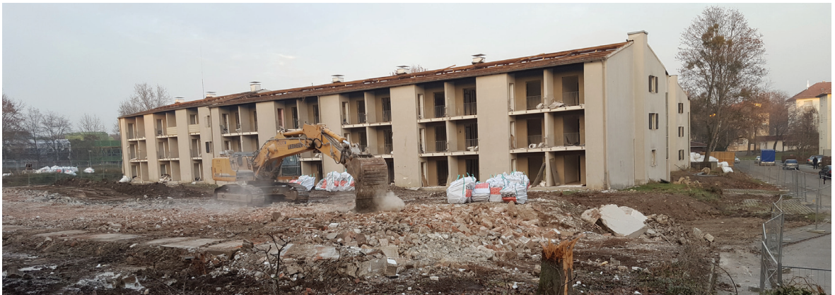
Abbruch der letzten Gebäude in der Lübecker Straße, Dez. 2016
