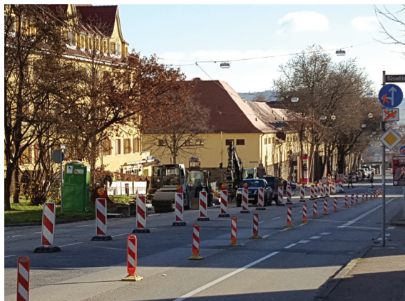
Straßenbauarbeiten im Hallschlag in vollem Gang
