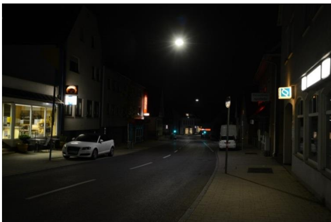
Filderhauptstraße mit LED-Beleuchtung
