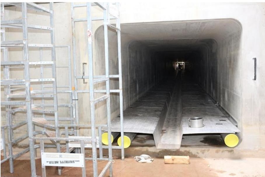
**Bild 58** Eingebaute Wärmetauscherelemente im Abwasserkanal
