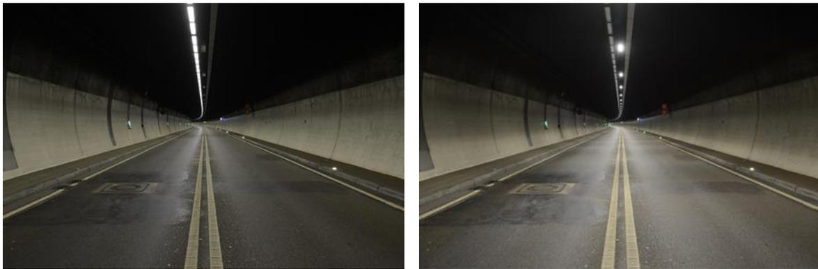
**Bild 36** Alte (links, durchgängiges Lichtband) und neue Anlage (rechts) der Durchfahrtsbeleuchtung
