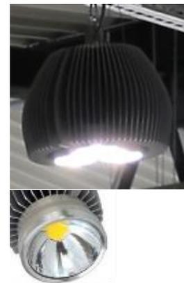
**Bild 40** Neuer Zustand 50 LED Hallentiefstrahler je 3 x 100 W
