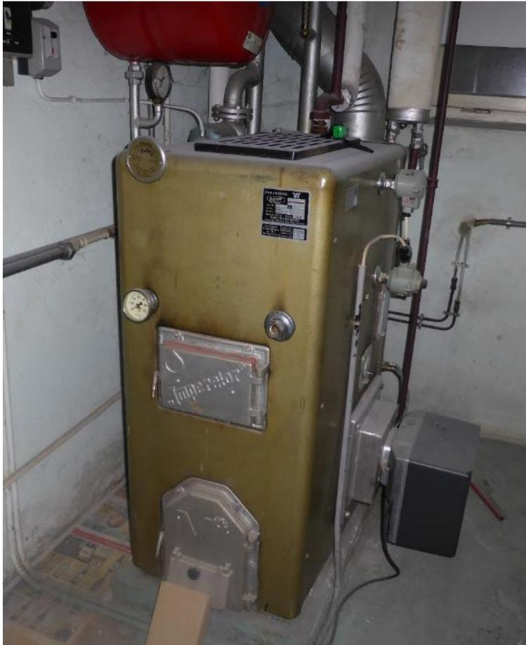
**Bild 12** Öl-Kessel aus dem Jahr 1958 (Quelle: EBZ)
