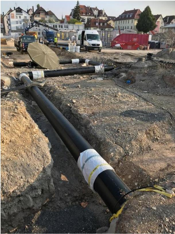
**Bild 57** Bau des Nahwärmenetzes
