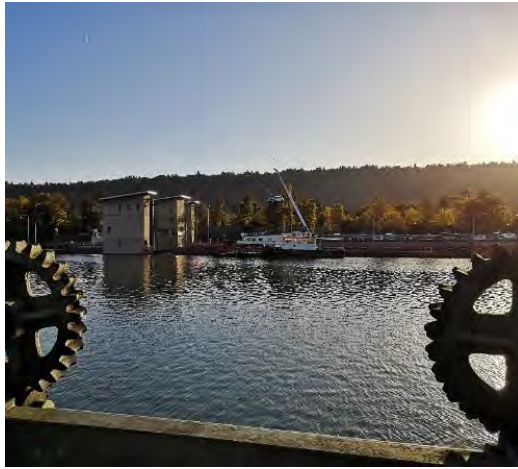
Schleuse im Bereich der Straße „am Ölhafen“
