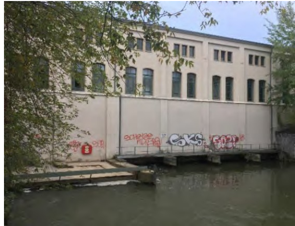
Wasserauslass nach Energiegewinnung das Kraftwerk
