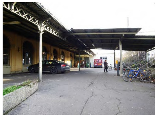
Rückseite des Bahnhofs mit Treppenabgang (rechts) zur Unterführung zu den Gleisen
