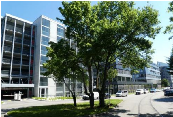
Neues Gebäude von Trelleborg mit gestapelter Parkierung im SynergiePark
