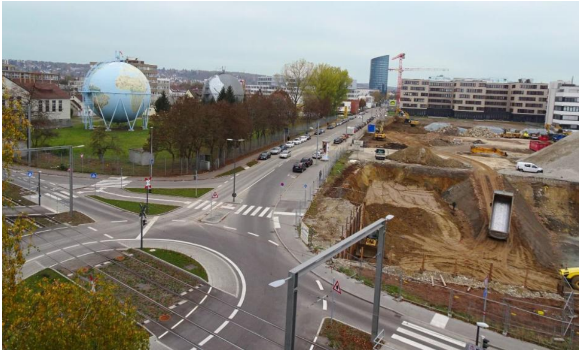
Kreuzungsbereich Am Wallgraben / Industriestraße in der Mitte des SynergieParks mit dem EnBW-Areal, Juni 2017
