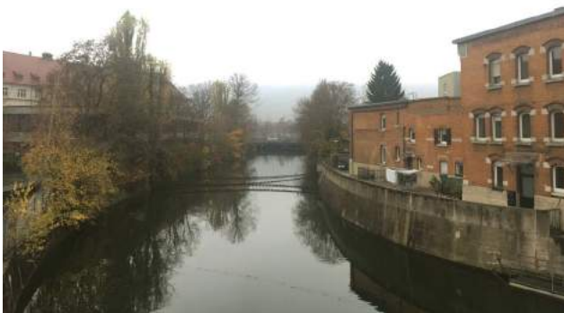
Abb. 14 Kanal und denkmalgeschützte Wohnbebauung EnBW
