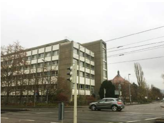
Abb. 17 Zugang zur Straße „Zum Ölhafen“
