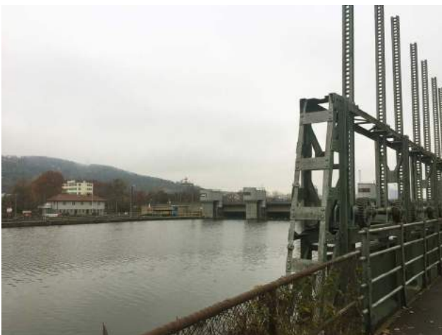
Abb. 6 Neckar mit Blick auf die Schleuse
