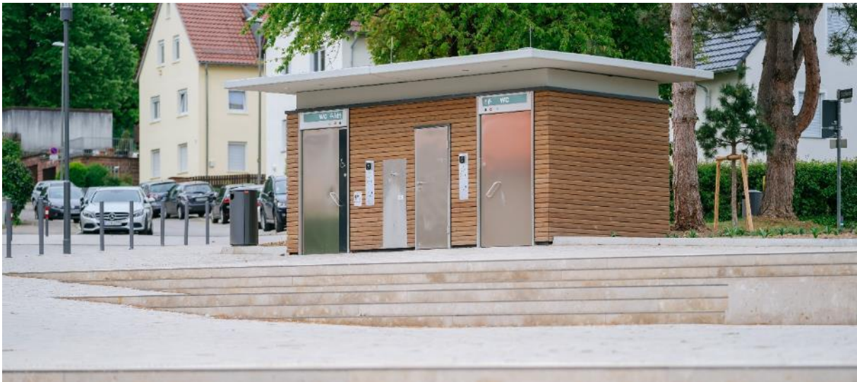
Abbildung 10 Toilettenanlage Kelterplatz Hofen
