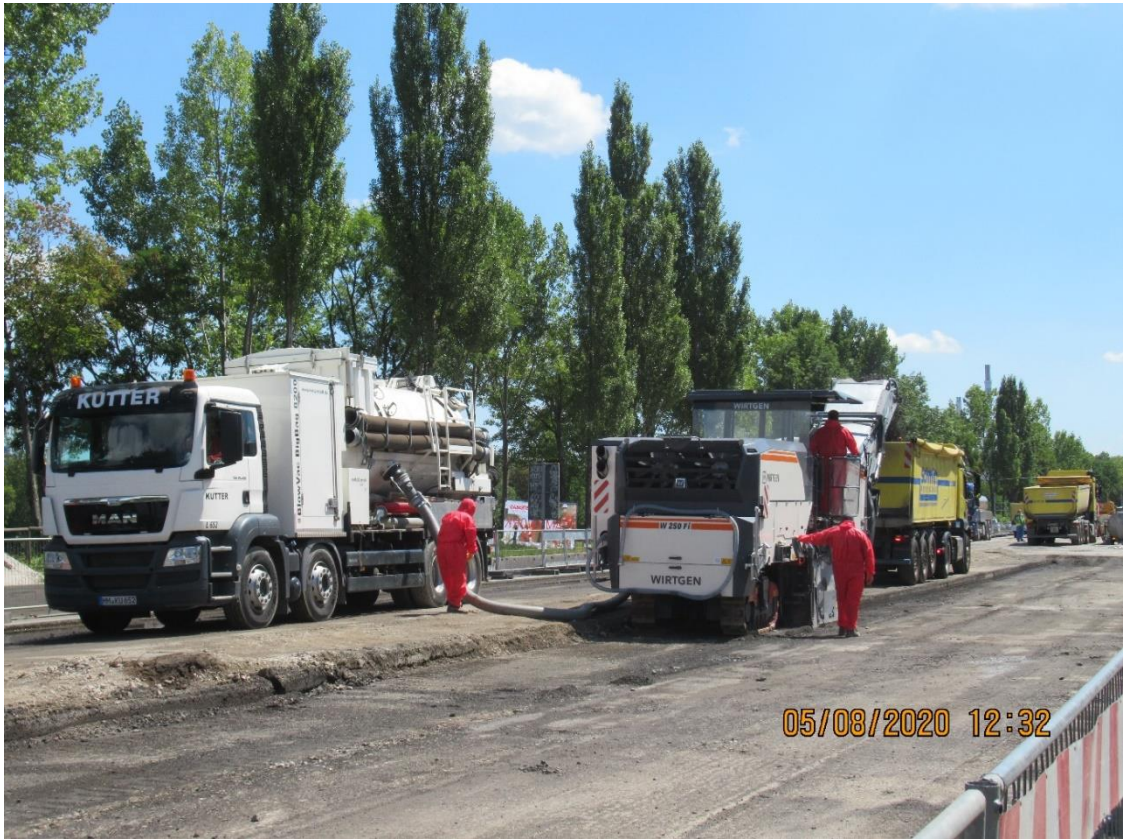
Abbildung 7: Sanierung der Uferstraße
