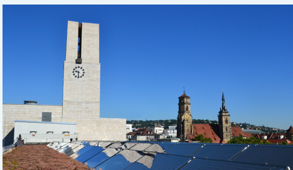
Solarzellen auf dem Dach der Rathauspassage mit Blick auf den Rathausturm.
