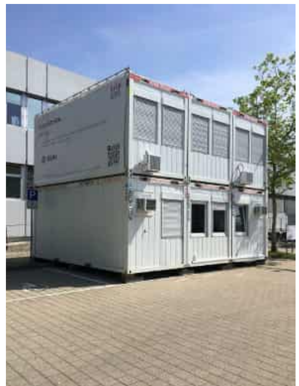
Hochschule der Medien: GENERATOR (temporäre Ergänzung des Raumangebots)
