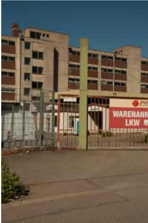
Transformationsquartier Wangen-Nord, Viehwiesen
