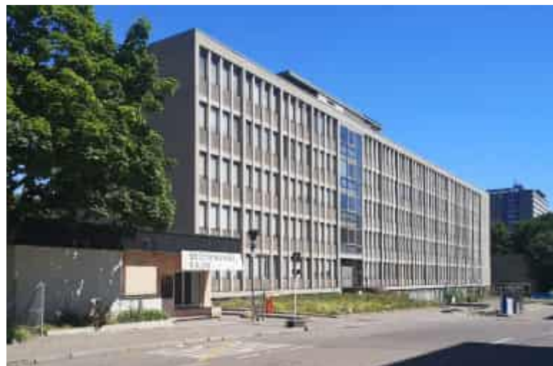
Campus Stadtmitte (Universität Stuttgart): Start-up Space im Bau 5, Breitscheidstraße
