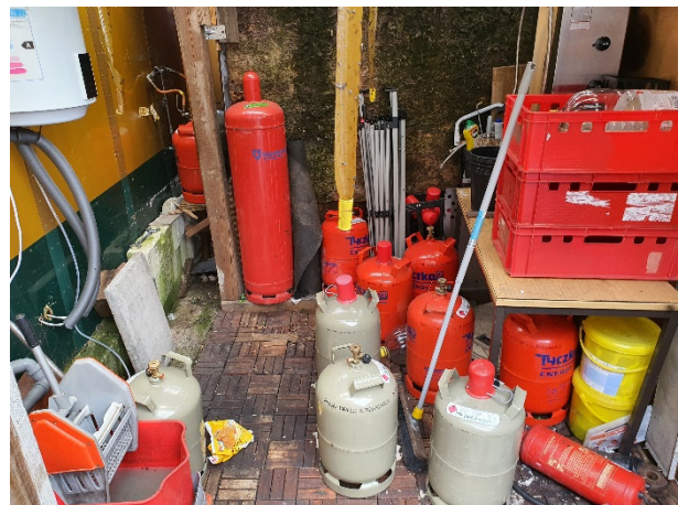
Bild 23: Überschrittene Anzahl an Flüssiggasflaschen
