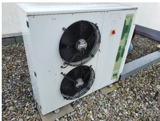
Bild 2: Klimagerät in Split Bauweise
