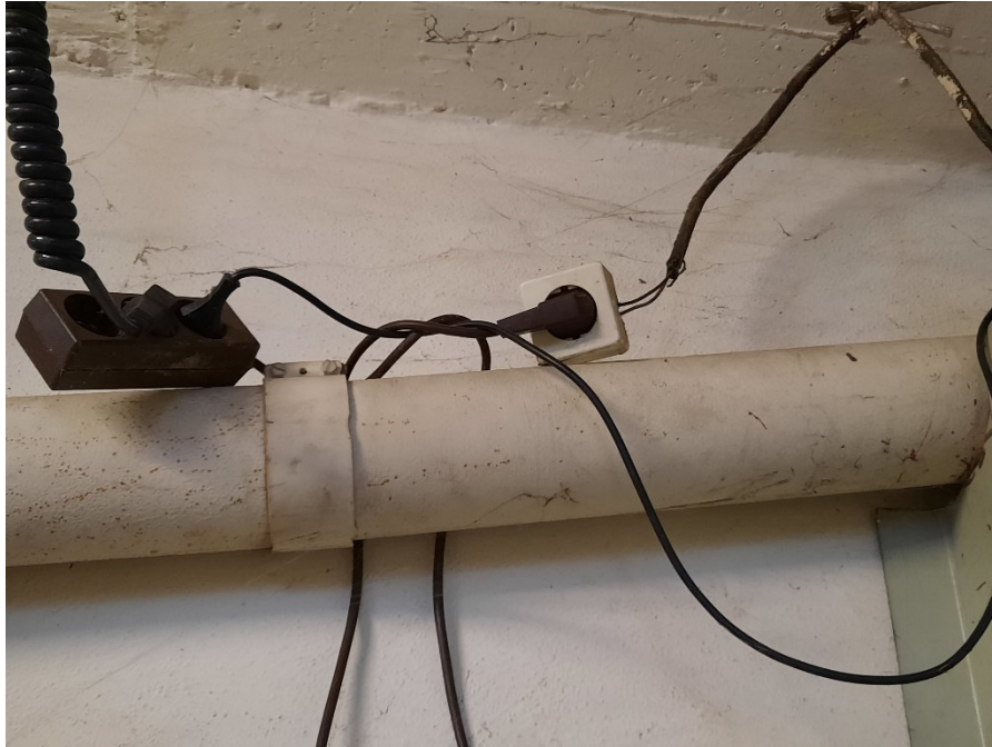
Bild 9: Unsachgemäße Elektroinstallation
