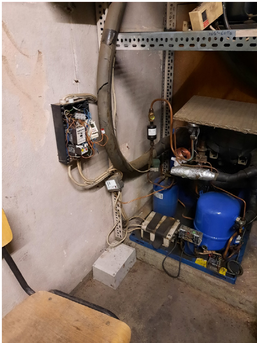
Bild 10: unsachgemäße Elektroinstallation
