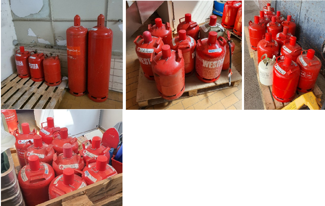
Bilder 11 bis 14: Angetroffene Gasflaschenlagerung in ungeeignetem Abstellraum
