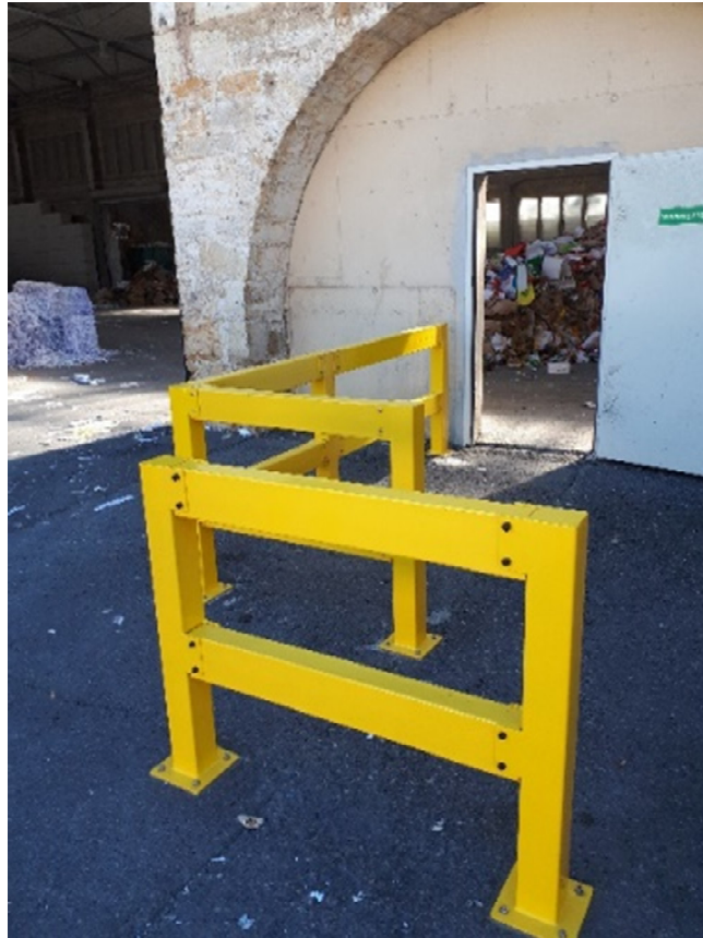
Bild 18: Neu montierter Anfahrtschutz
