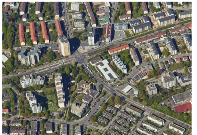
Großwohnsiedlung mit Erneuerungsbedarf - Zuffenhausen-Rot
