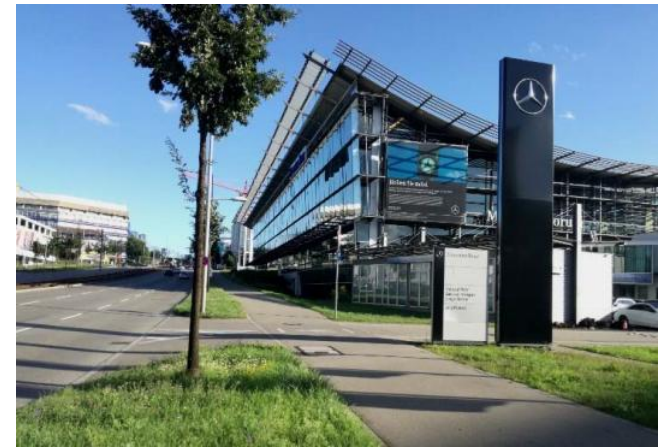
„Automeile“ (Heilbronner Straße) - Daimler Showroom
