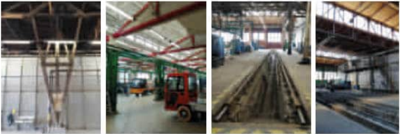
20-23 nördlicher Lokschuppen mit Dachtragstruktur aus Holz und teilweise durch neue Statikstrukturen ergänzt
