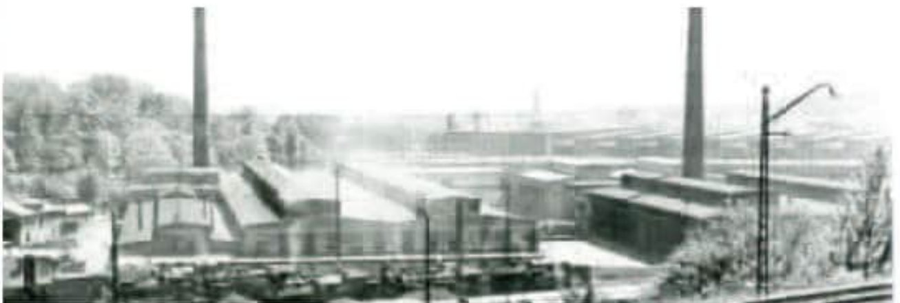
19 | Ursprüngliches Gebäudeensemble des Lokschuppens (links nördlicher und rechts südlicher Lokschuppen)
