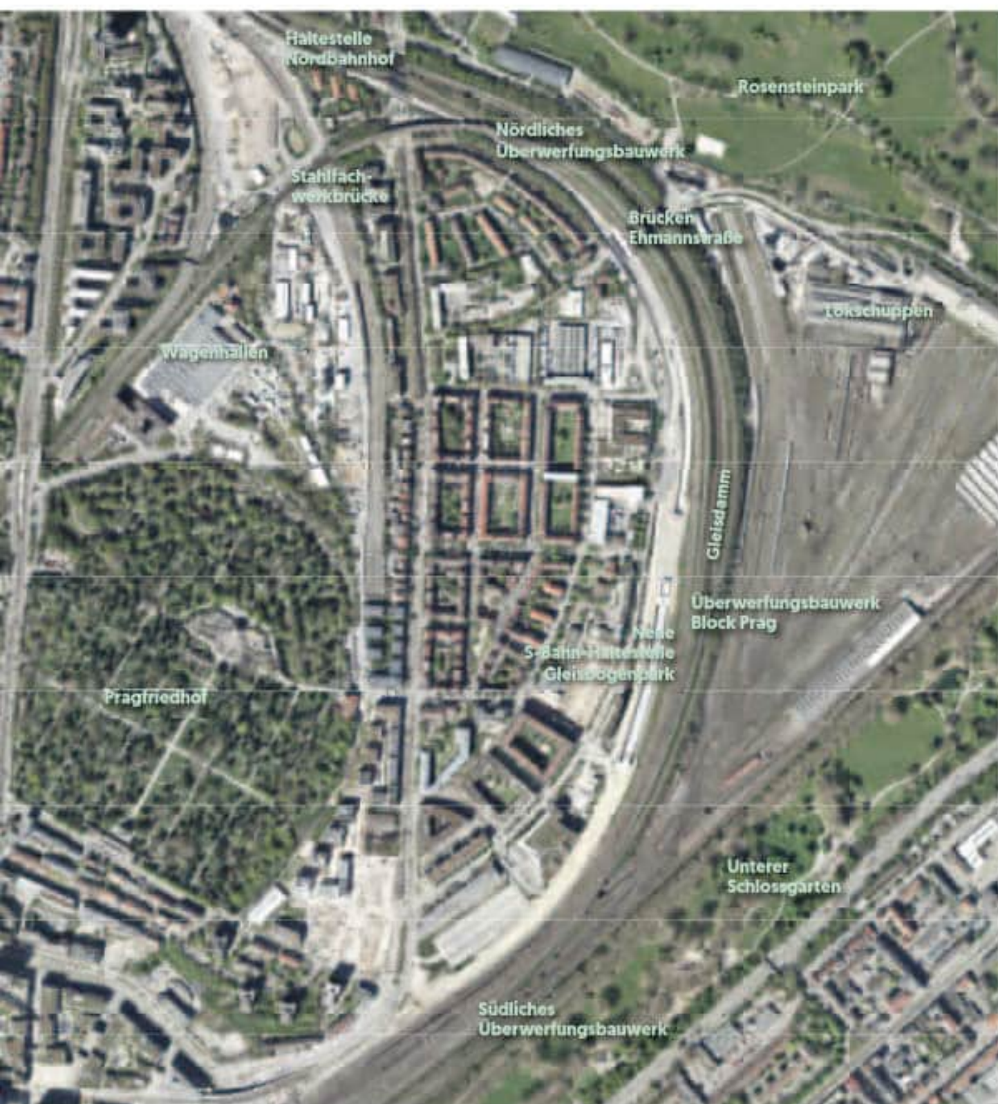
1 | Blick in Richtung Rosensteinpark mit Gleisdamm und denkmalgeschützten Bahnbauwerken.
