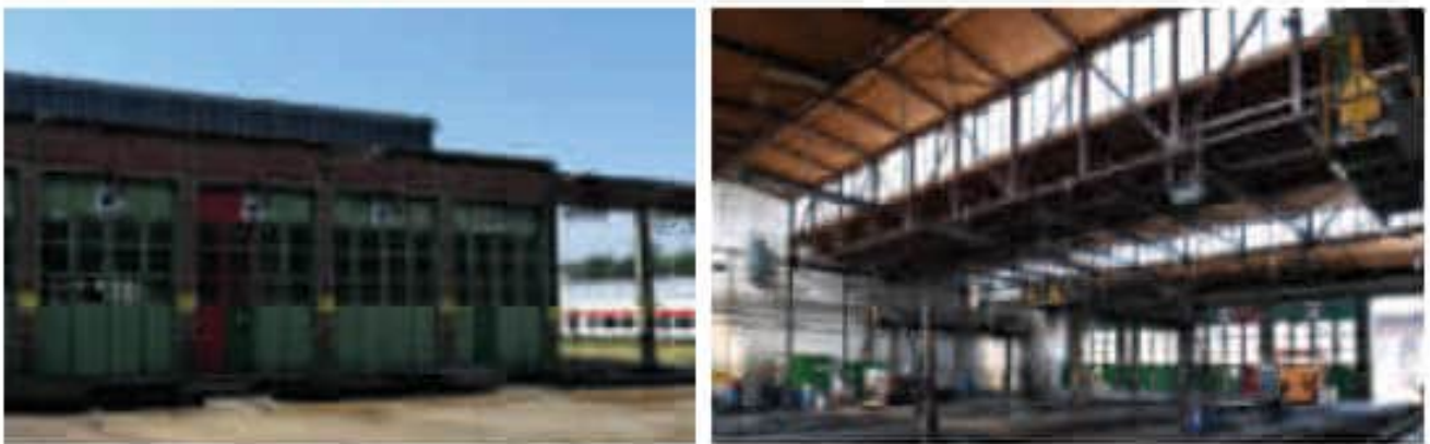
24-25 südlicher Lokschuppen von außen mit Zugang zu Glaswände (links), südlicher Lokschuppen mit Stahlachswerkkonstruktion (rechts)
