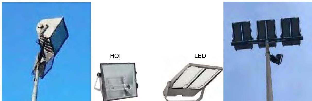
**Bild 56** Flutlichtstrahler vor und nach der Sanierung
