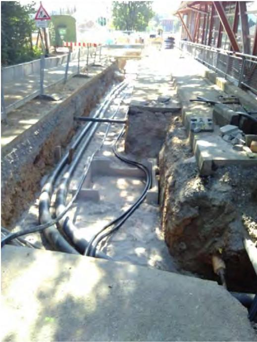
**Bild 41** Nahwärmeleitung und Erdkabel zwischen Eiswelt (rechts) und Baustelle der Sporthalle Waldau (links)
