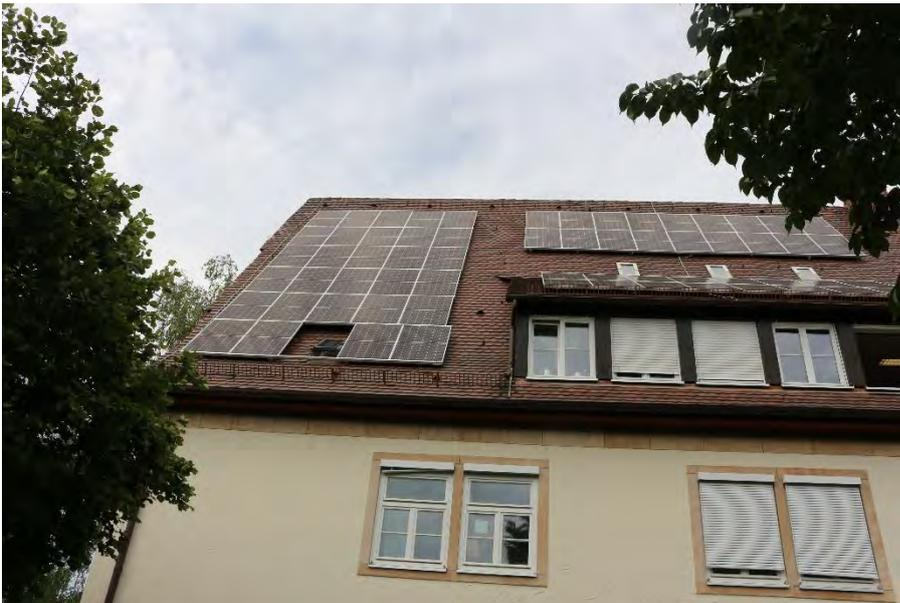
**Bild 77** Insgesamt 86 Solarmodule wurden auf das Dach des Spitalhofs montiert
