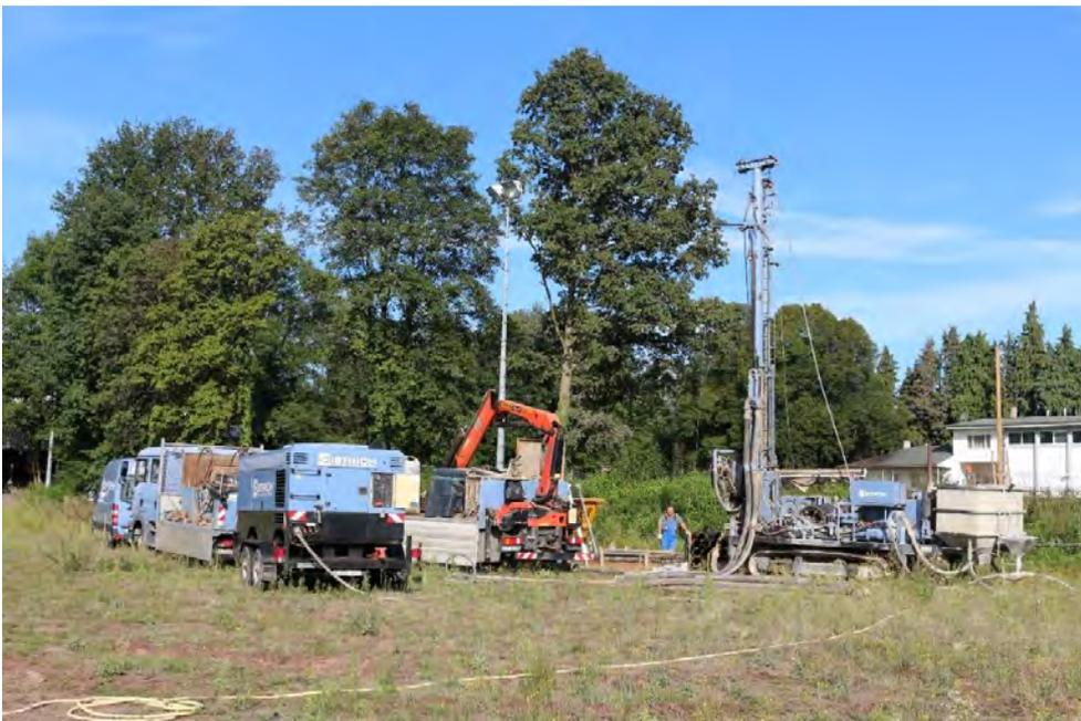
**Bild 42** Bohrung der ersten Erdwärmesonde auf dem Baufeld der Sporthalle Waldau
