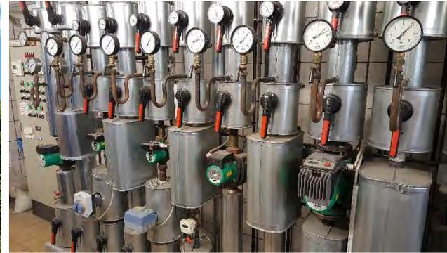
**Bild 43** Königin-Katharina-Stift mit Blick auf das Hauptgebäude **Bild 44** Heizkreisverteiler zur Wärmeverteilung
