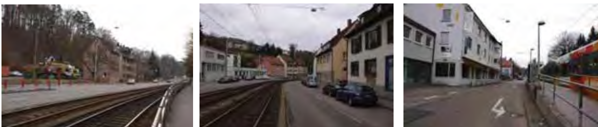
Dominanz der Verkehrsfunktion mit hoher Stör- und Trennwirkung in der Böblinger Straße
