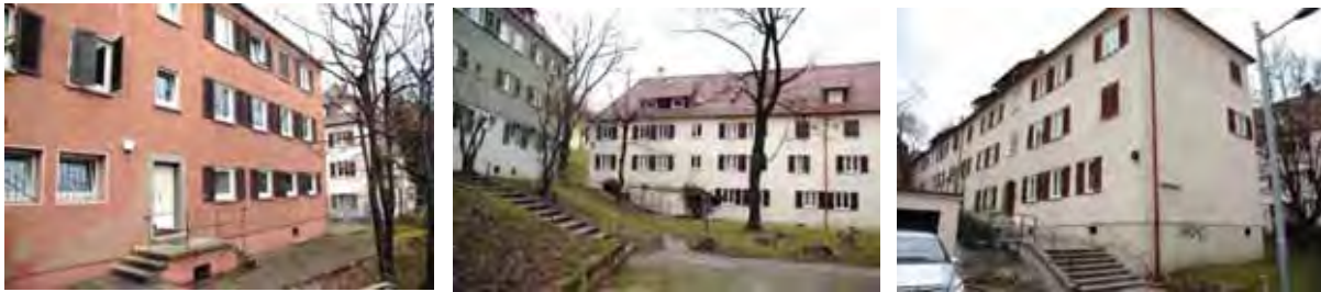
Wagenburgsiedlung: Modernisierungsbedarf und mangelnde Gestaltung der Freiflächen
