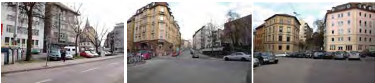
Funktionale und gestalterische Mängel von zentralen Platzbereichen und fehlende Aufenthaltsqualität
