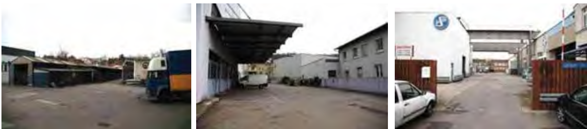
Brache Schoch-Areal mit Störwirkung auf angrenzende Wohnbebauung und fehlender Durchwegung
