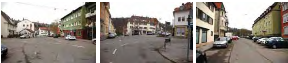
Funktionale und gestalterische Mängel wichtiger Platz- und Freibereiche entlang Alte Stuttgarter Str.
