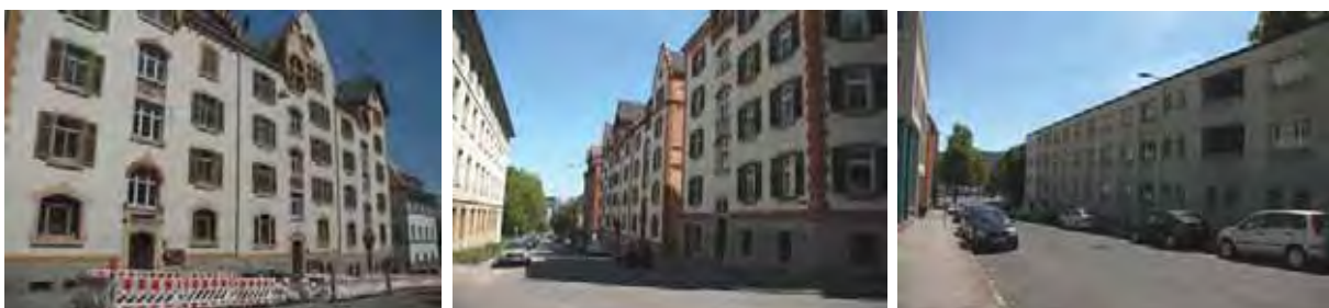
Defizite im Wohnbaubestand und öffentlicher Raum Türlenstraße, Tunshofer Straße, Wolframstraße
