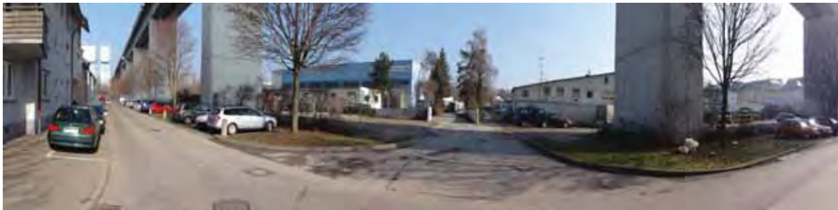
Prägung der Bestandssituation durch das Neckarviadukt
