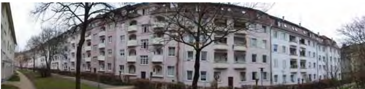
Energetische Defizite in den Wohnungsbeständen im Nordbahnhofviertel sowie hohe bauliche Dichte
