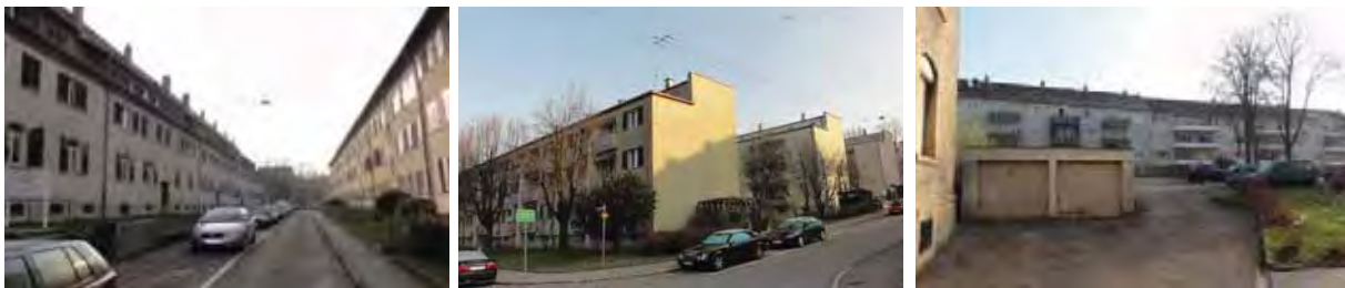
Defizite im Wohnbaubestand im Quartier Wallmer
