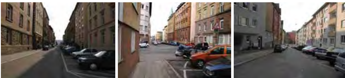
Defizite in der Gestaltung des öffentlichen Raums mit Störlwirkung auf das Wohnumfeld
