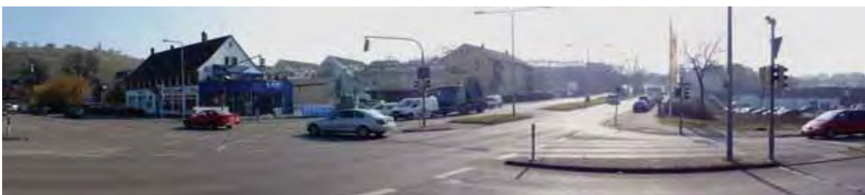
Prägung des Ortsauftakts durch den Knotenpunkt Gnesener Straße/Hofener Straße
