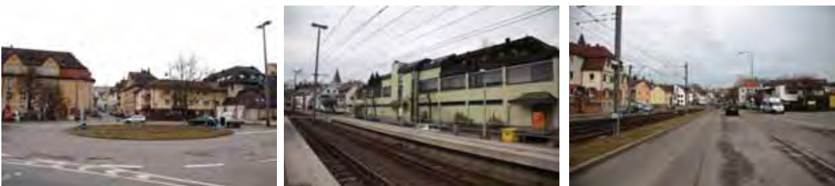
Hohe Trennwirkung durch Regerstraße und Kauffmannstraße, Störwirkung auf den öffentlichen Raum
