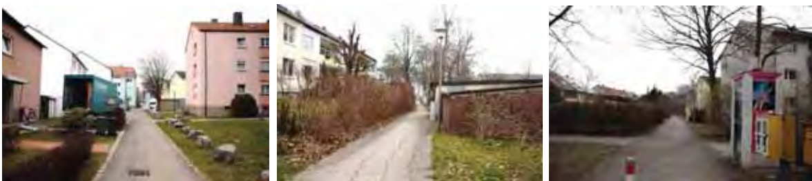
Fehlende Ablesbarkeit und mangelnde Gestaltung zentraler Fuß- und Radwegebeziehungen
