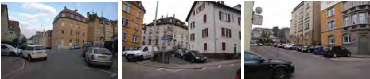
Defizite im öffentlichen Raum: Gestaltung der Platz-/Kreuzungsbereiche westl. Karl-Kloß-Straße
