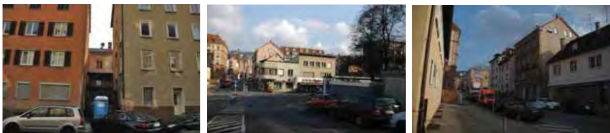
Modernisierungsrückstände und funktionale Defizite zwischen der Tübinger und Hauptstätter Straße
