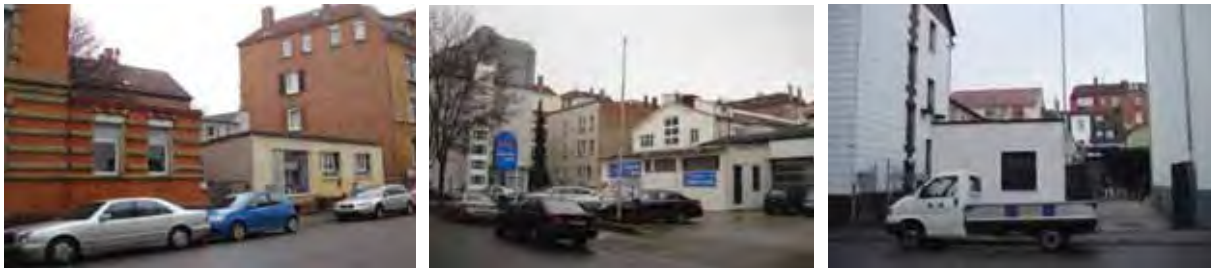
Defizite in den Blockinnenräumen im Quartier Seelberg
