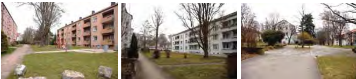
Mangelnde Gestaltung und geringe Nutzbarkeit privater Freiflächen zwischen den Gebäudezeilen
