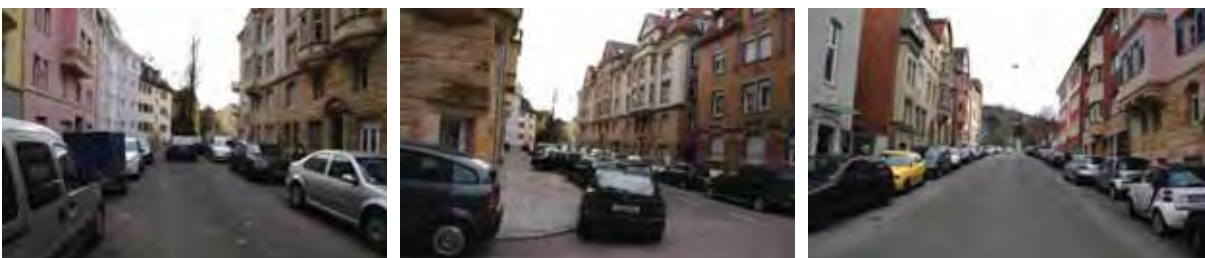
Mangelnde Gestaltung und funktionale Defizite, Dominanz des ruhenden Verkehrs
