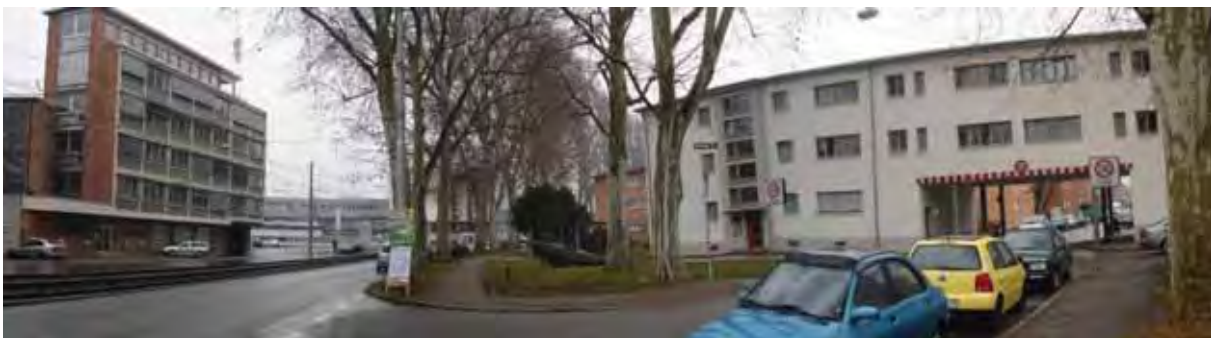
Zäsur der Inselstraße und Siedlung Inselstraße
