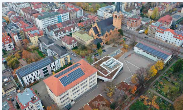
Die Photovoltaik-Anlage auf den Dächern der Martin-Luther-Schule kann rechnerisch 80 Drei-Personen-Haushalten mit Solarstrom versorgen.
