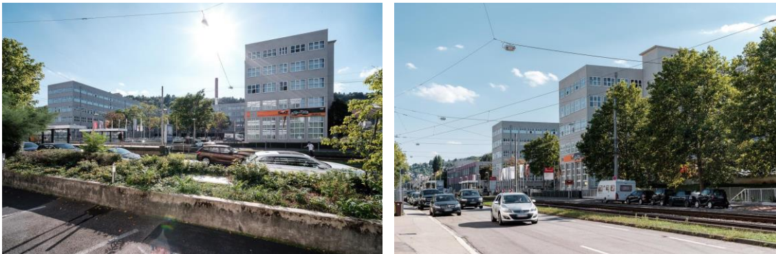
Abbildungen: Gebäudebestand des Kodak-Areals in Stuttgart Wangen
