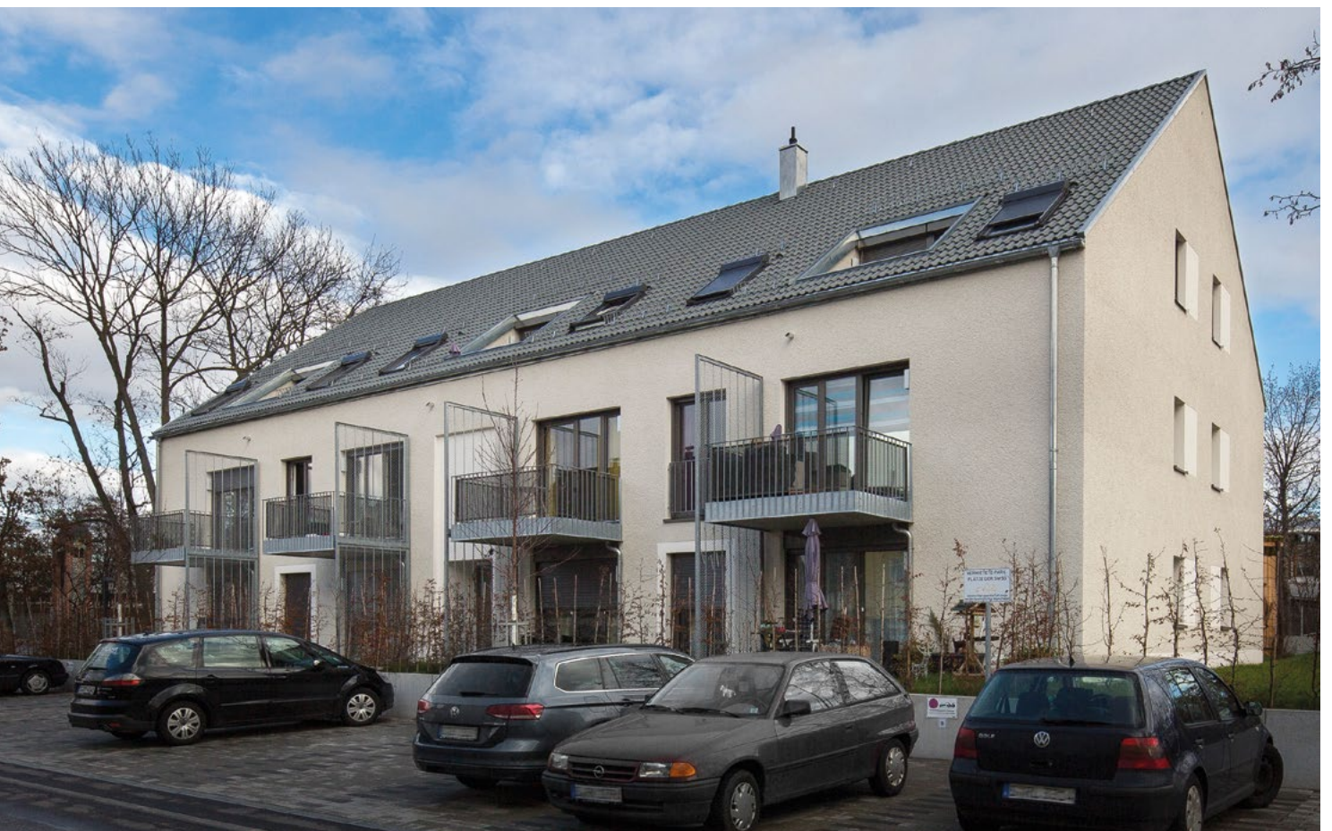
Neubau von 11 Sozialmietwohnungen in der Gingener Straße in Stuttgart-Wangen , Bezug: November 2019 (Foto: SWSG)
