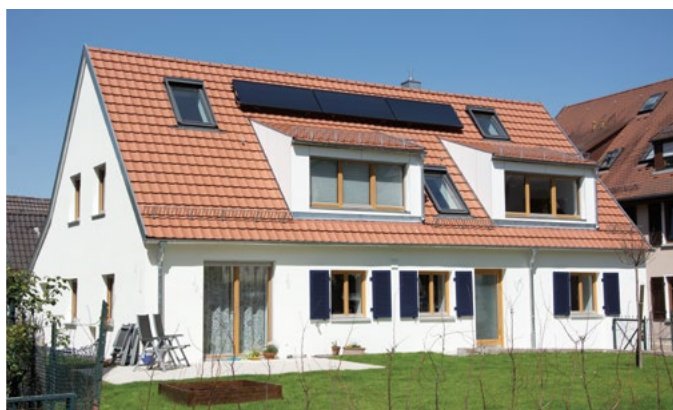
Wohnhaus in Hedelfingen vor und nach der energetischen Sanierung. Der Endenergiebedarf konnte um 63 Prozent reduziert werden (Fotos: Energieberatungszentrum Stuttgart e.V.)
