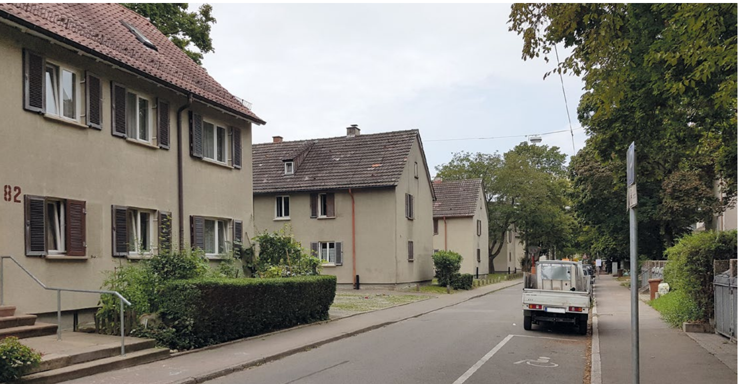
Geplante Neuordnung und Verdichtung des Quartiers an der Düsseldorf/Bottroper Straße im Hallschlag: Abriss von 110 Wohneinheiten und Ersatzneubau von ca. 320 Wohnungen (Foto: Tobias Held)
