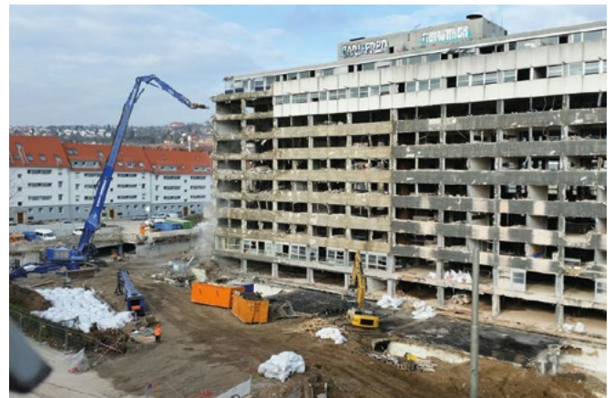
Olga-Areal: Abriss des Olga-Hospitals in zentraler Lage des Stuttgarter Westens (Foto: Liegenschaftsamt)
