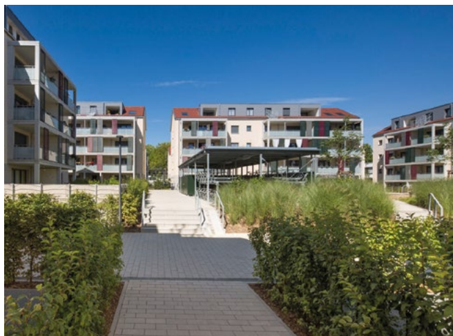
Ersatzneubau nach dem Stuttgarter Innenentwicklungsmodell im Gebiet Lübecker/Dessauer Straße auf dem Hallschlag: In zwei Bauabschnitten sind insgesamt 161 neue Wohnungen, davon 53 Sozialwohnungen sowie 30 geförderte Mietwohnungen für mittlere Einkommensbezieher, entstanden. Bezug: Mai bis August 2019 (Foto: SWSG)
