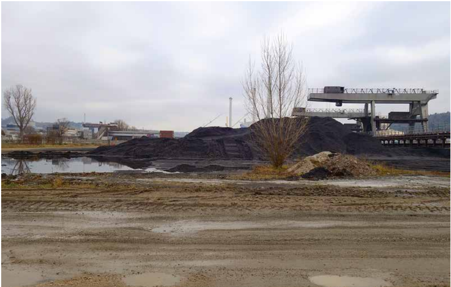
Kohlehalden mit Verladekräne und Kohlebandbrücke im Hintergrund
