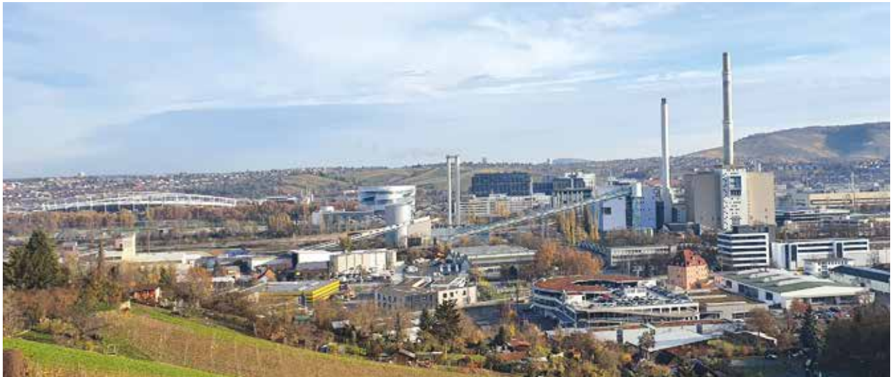
Blick von der Gaisburger Hanglage nach Osten auf das Neckartal (2020) – rechts im Vordergrund das Kraftwerk Gaisburg
