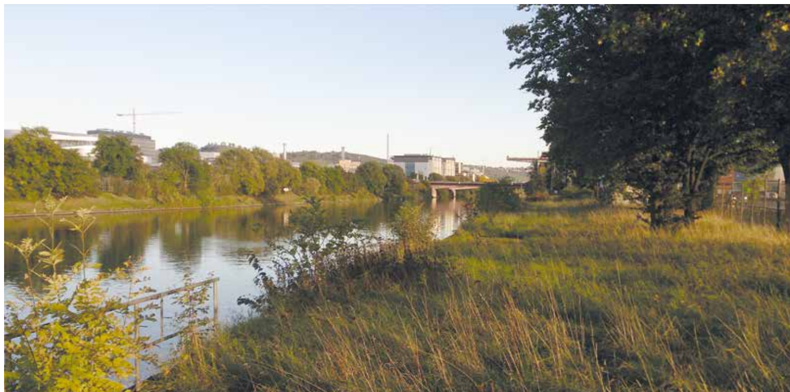
Neckarufer im Bereich des Kraftwerks Gaisburg, Blick nach Norden: (von links nach rechts) das Mercedes-Benz-Museum, rechts im Vordergrund der schmale Fuß- und Radweg, die Bundesstraße B10 / 14 und das Kraftwerk Gaisburg
