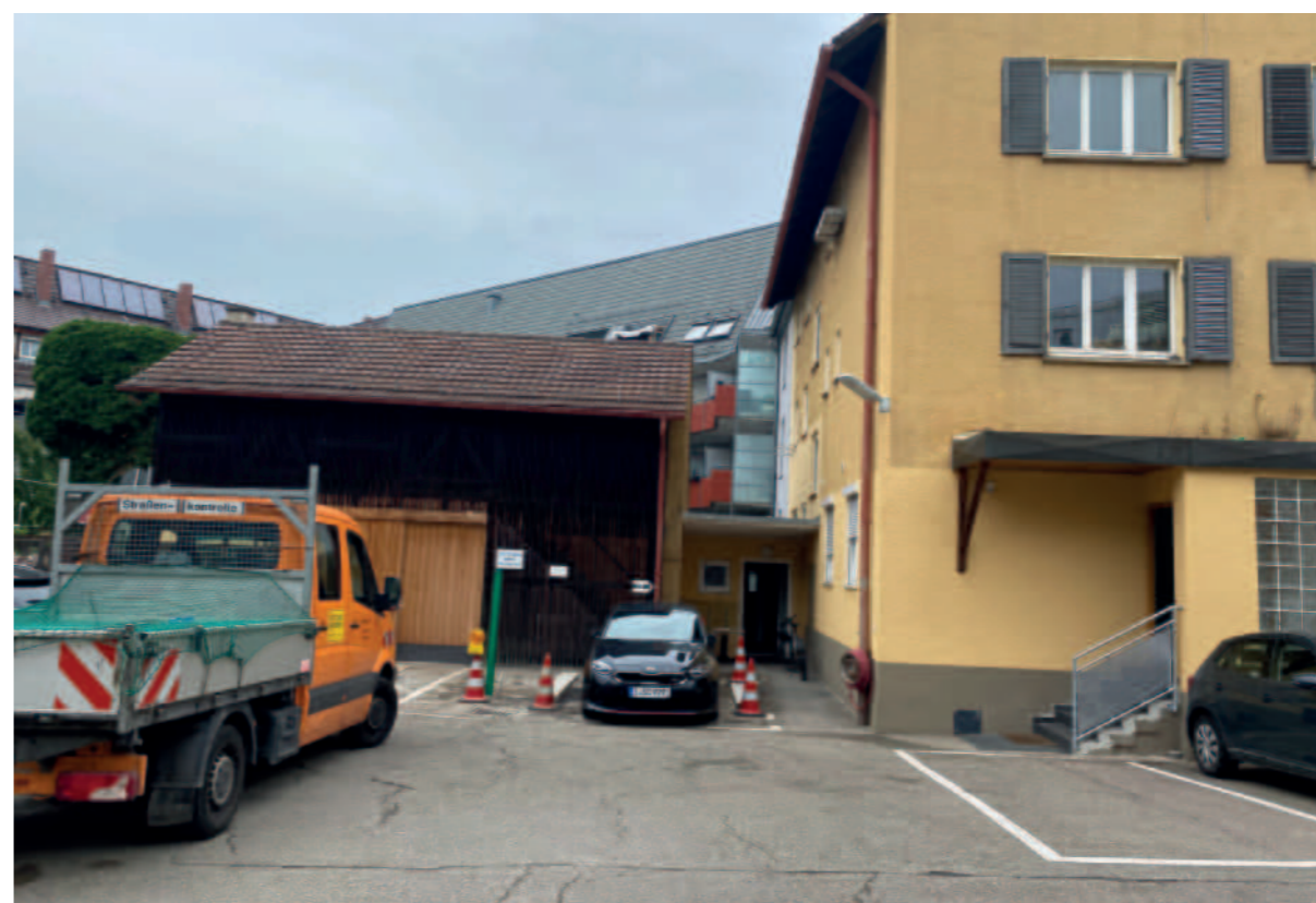
Scheune und Bestandsgebäude
