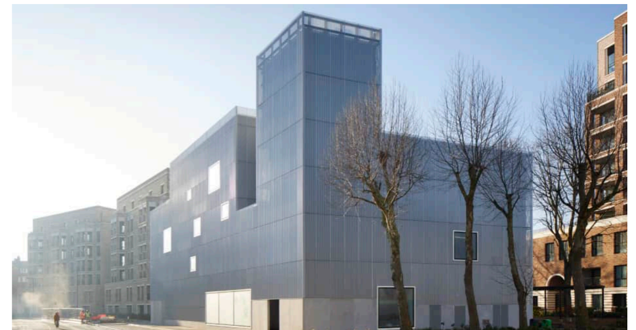
Blockheizkraftwerk, Kita und Café, London, Fotografie: Jack Hobhouse
