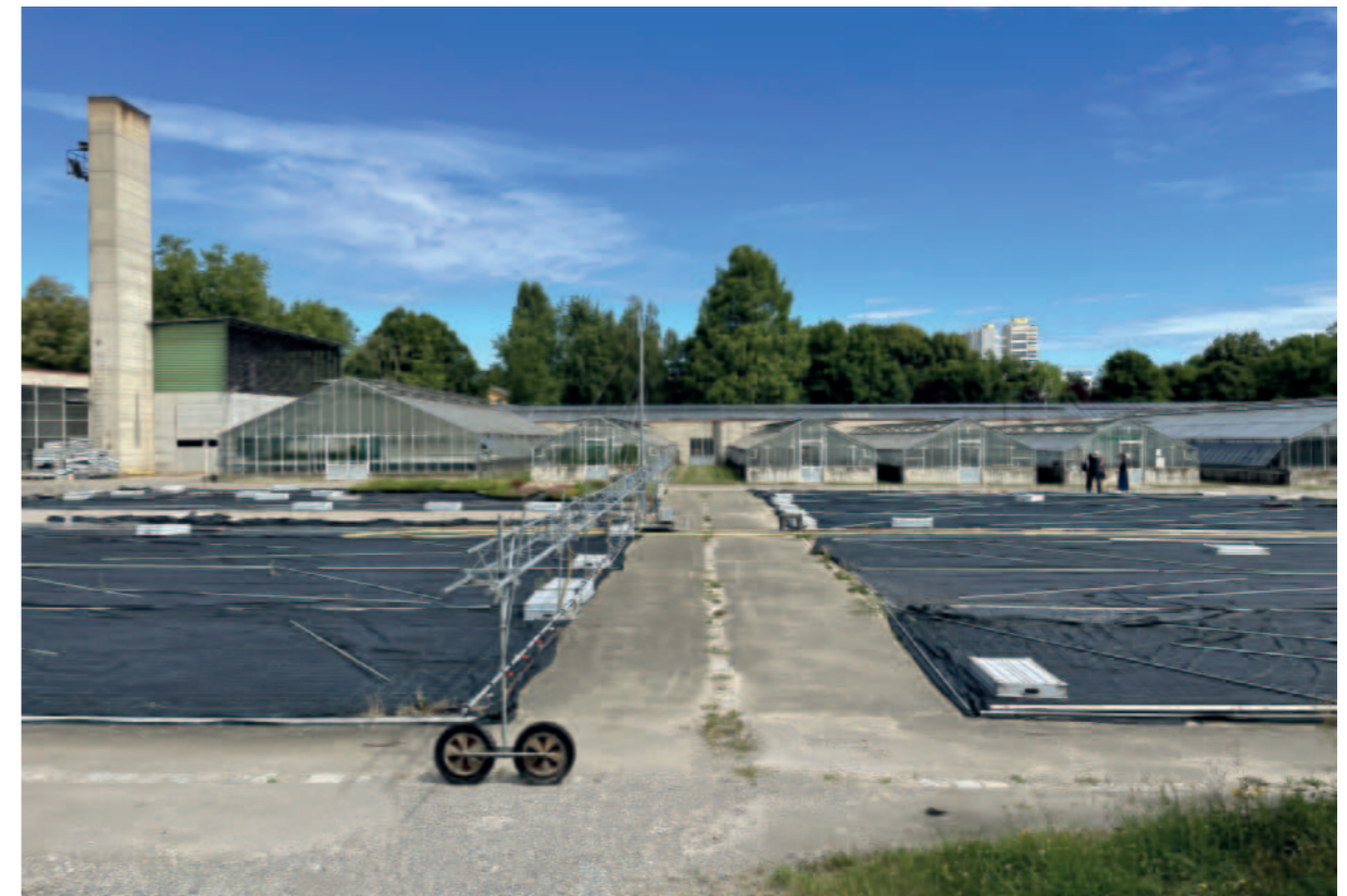
Blick auf die bestehenden Gewächshäuser
