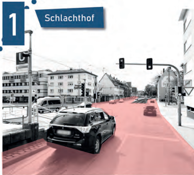
Eingang zur Tallängsachse: Haltestelle Schlachthof an der Kreuzung Talstraße / Ulmer Straße
