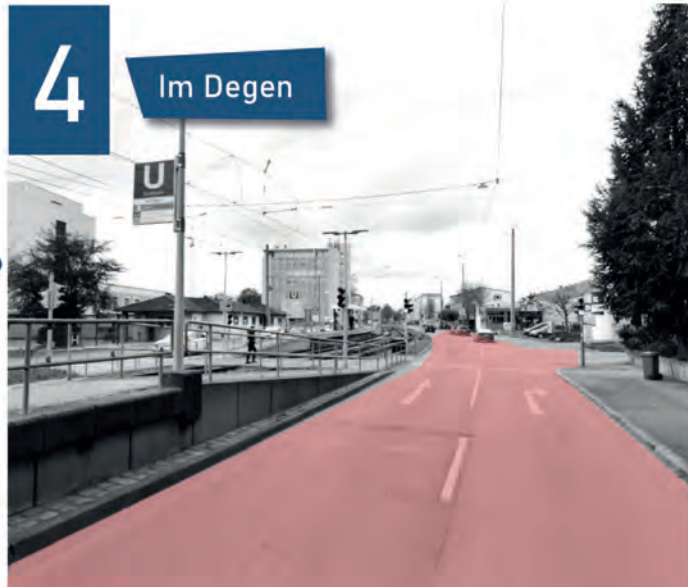
Wenig einprägsame Bebauung auf Höhe der Haltestelle
