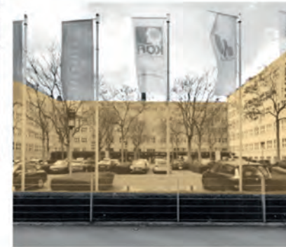
Innenhof des Kodak-Areals, aktuell genutzt als Stellplatzfläche
