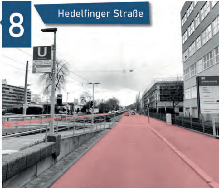
Das Kodak-Areal (rechts im Bild) und die Flächen der SportKultur Stuttgart e.V. (links im Hintergrund, nach der Tankstelle)
