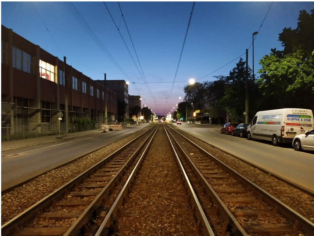
Abbildung 5.7: Besondere Herausforderung in der Hedelfinger Straße war die Umrüstung der Beleuchtung im Bereich der Fahrleitung.
