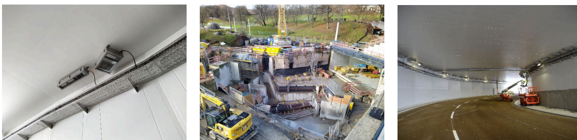
Abbildung 5.4: Durchfahrt- und Adaptionleuchte sowie Versorgungskabeltrasse (links) und Blick in die Baugrube (mitte), Blick in den Tunnel während der Umbauarbeiten (rechts)
