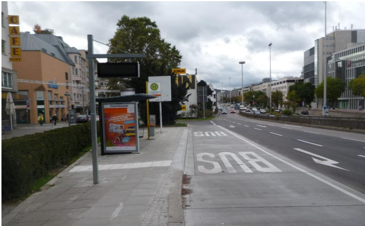
Bild4: Charlottenplatz/Hauptstätter Straße, Kombibord und Betonfahrbahn
