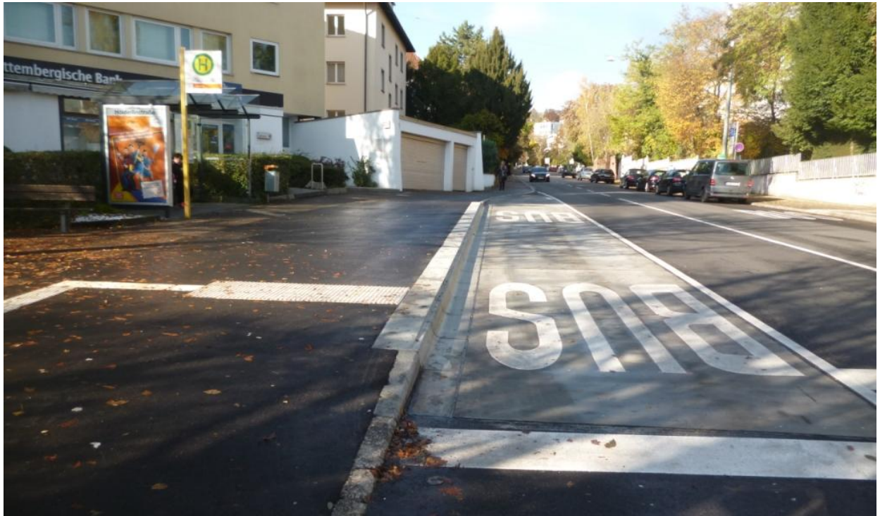
Bild3: Hölderlinstraße/Herdweg, Kombibord, Betonfahrbahn
