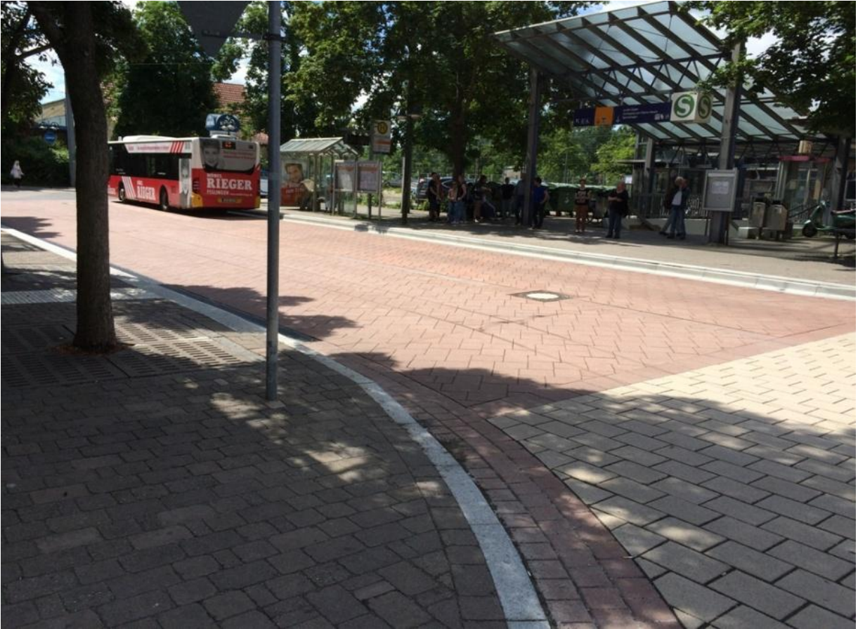
Bild5: Bahnhof Obertürkheim, Kombibord und Pflaster/System ecoprec
