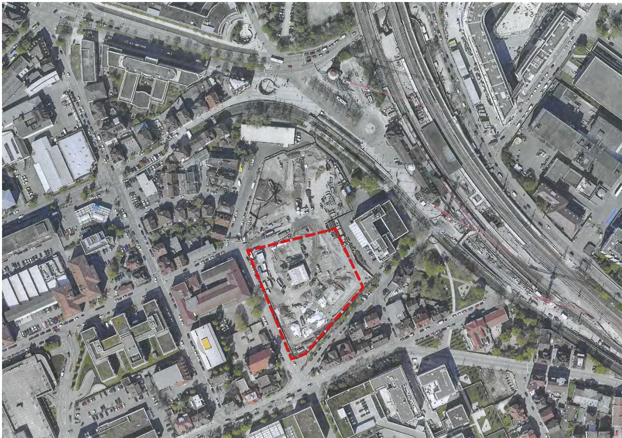
Abb. 4: Luftbild Quartier am Wiener Platz, Abgrenzung Baufeld Süd (2017) Quelle: LHS Stuttgart, Stadtmessungsamt Stuttgart
