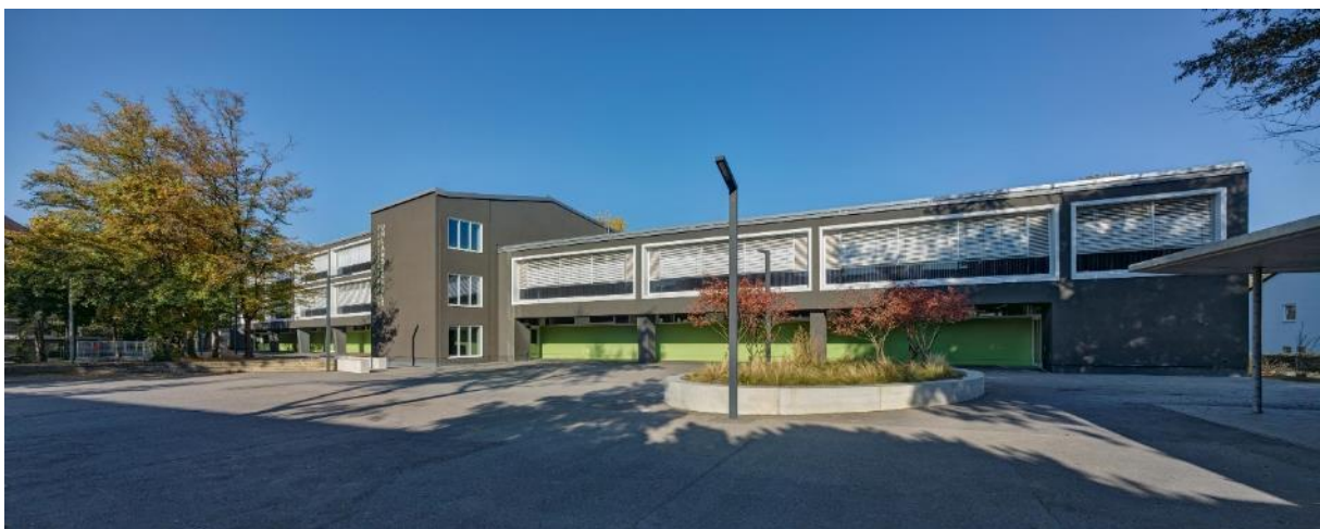
Bild 59 Südseite der sanierten Uhlandschule (Bildrechte: Saint-Gobain, Fotograf: Olaf Rohl)
