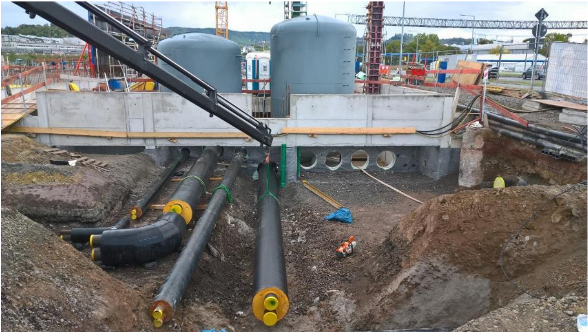
Bild 63 Anschluss der Nahwärmeleitungen
