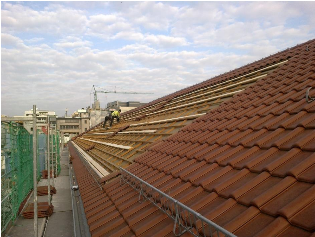
Bild 34 Arbeitsbeginn auf dem Altbaufügel des Stuttgarter Rathauses
