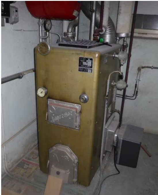
Bild 12 Öl-Kessel aus dem Jahre 1958 (Quelle: EBZ)
