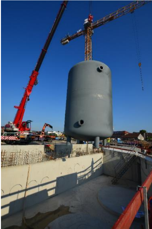
Bild 61 Einbringung Pufferspeicher
