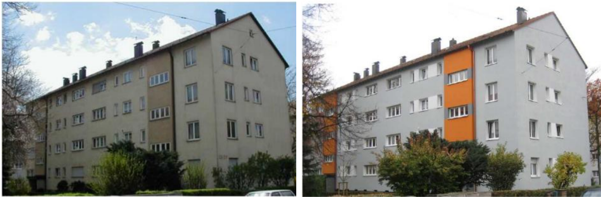
Bild 11 Sanierung im Rahmen des ESP (Quelle: Mader Architekten)
