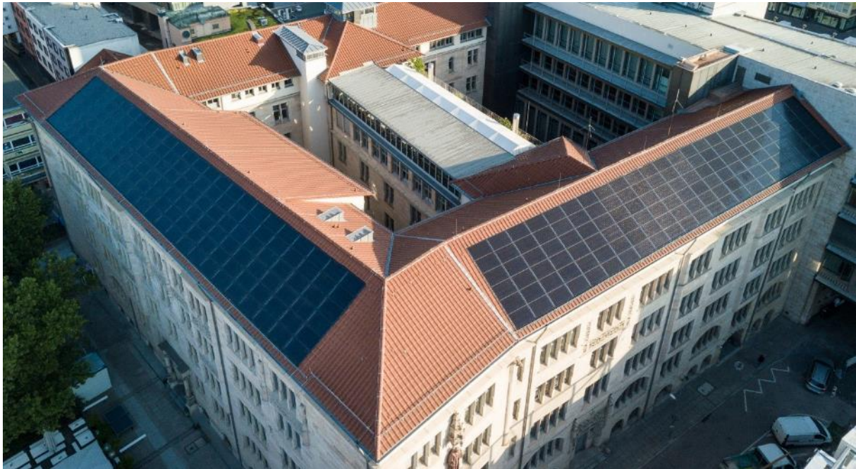
Bild 35 Fertige Indach-Photovoltaikanlage auf dem Rathaus-Altbau
