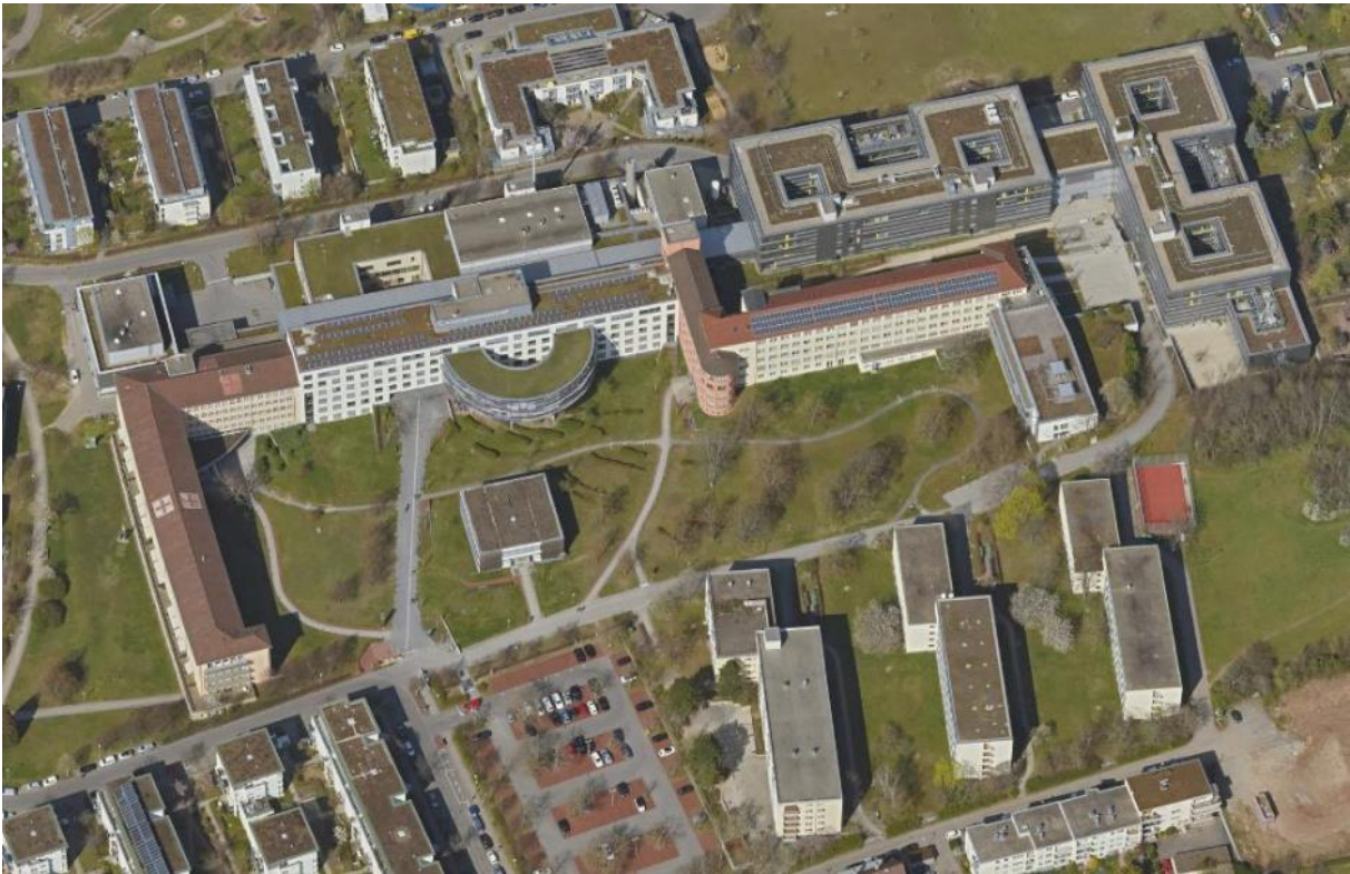
Bild 29 Luftbildaufnahme des Krankenhaus Bad Cannstatt 2019
