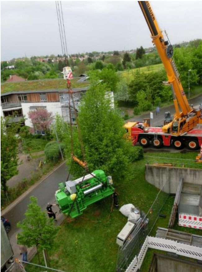
Bild 30 Einbringung des BHKW-Moduls
