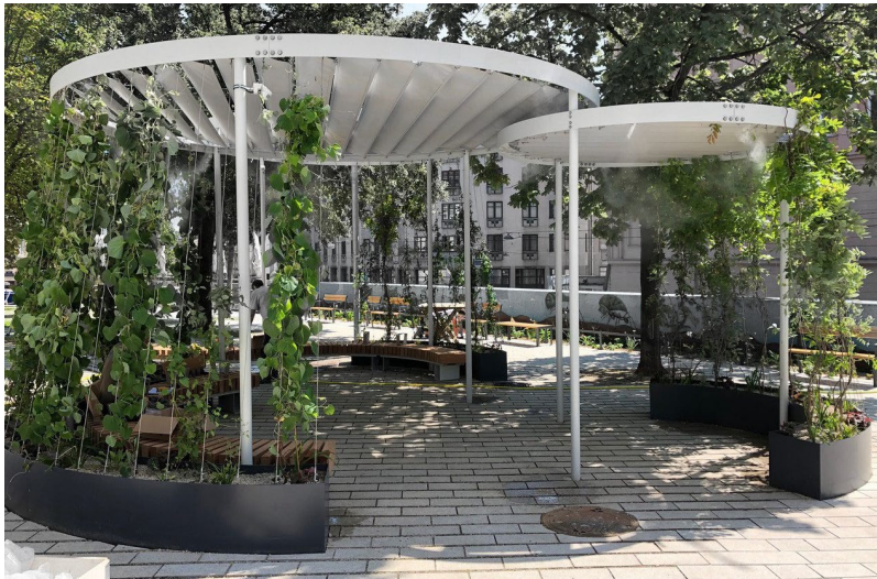
Cool-Spot als Kombination von Rankpflanzen, technischer Verschattung und Nebelementen (Tröpfel-Bad in Wien)
