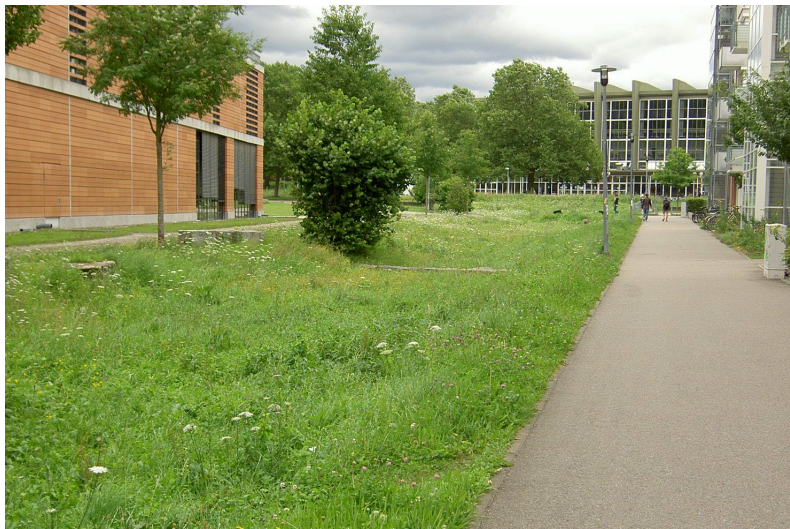
Speicherung und verzögerte Ableitung von Oberflächenwasser über begrünte Versickerungsfläche mit unterirdischen Rigolen (Mulden-Rigolen-System in Freiburg-Wiehre)
