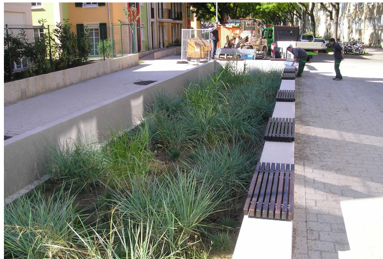
Speicherung und verzögerte Ableitung von Oberflächenwasser über ein schilfbepflanztes Becken (Freiburg Peter-Struck-Straße)
