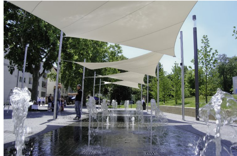
Technische Verschattung eines mit Basaltstein gepflasterten Stadtplatzes mit Wasser (Heilbronn Bollwerkplatz)
