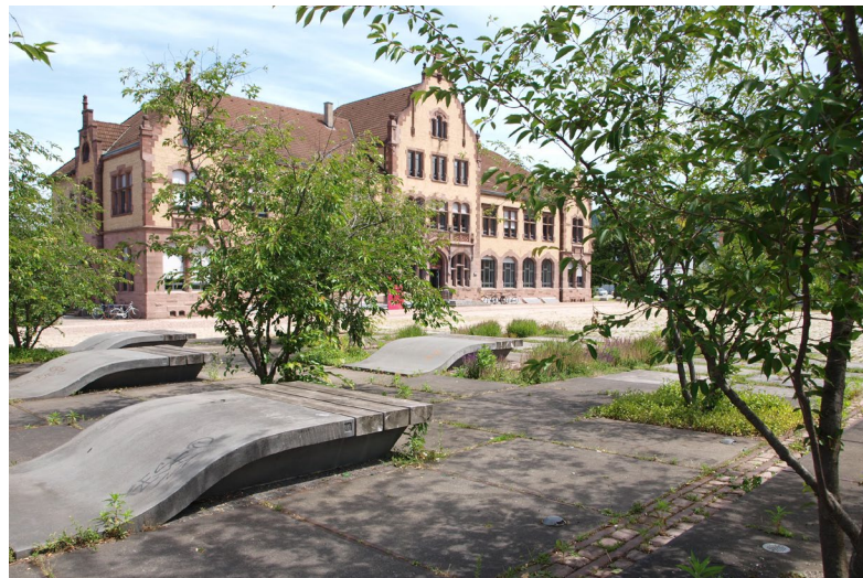
Speicherung und verzögerte Ableitung von Oberflächenwasser über begrünte Versickerungsflächen und unterirdische Rigolen (Freiburg Zollhallenplatz)
