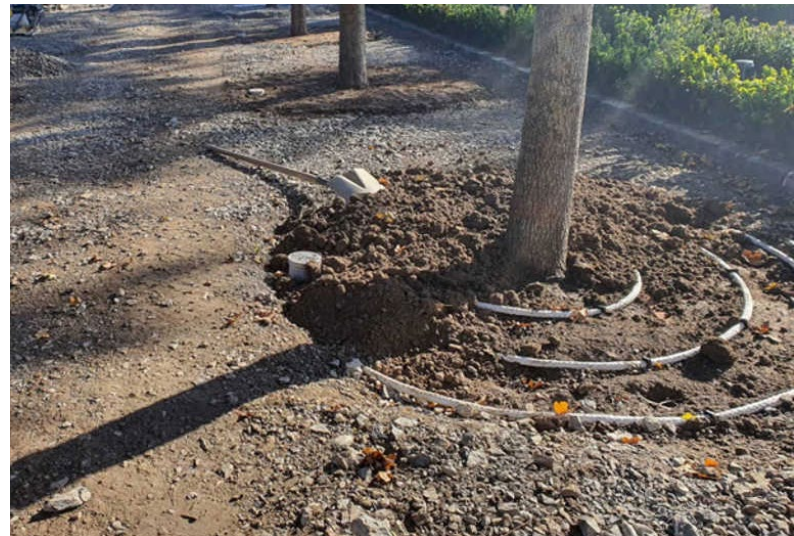
Baumbewässerung von Bestandsbäumen
