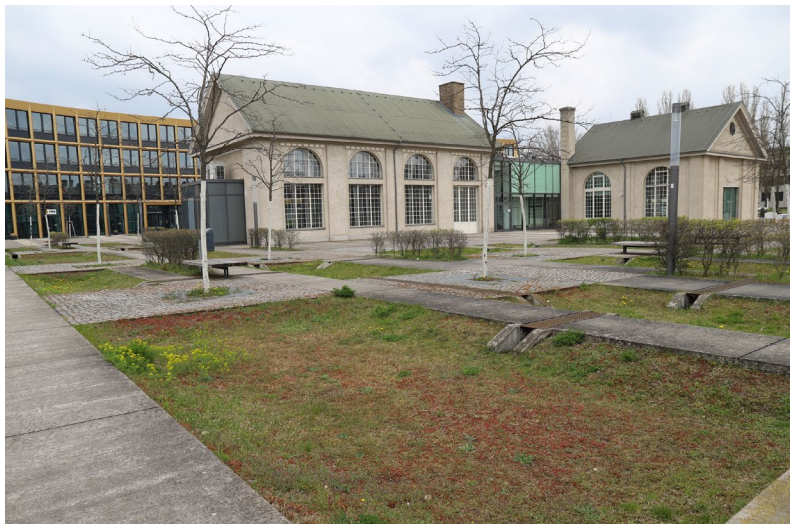
Speicherung und verzögerte Ableitung von Oberflächenwasser über begrünte Retentionsflächen (Berlin-Adlershof)
