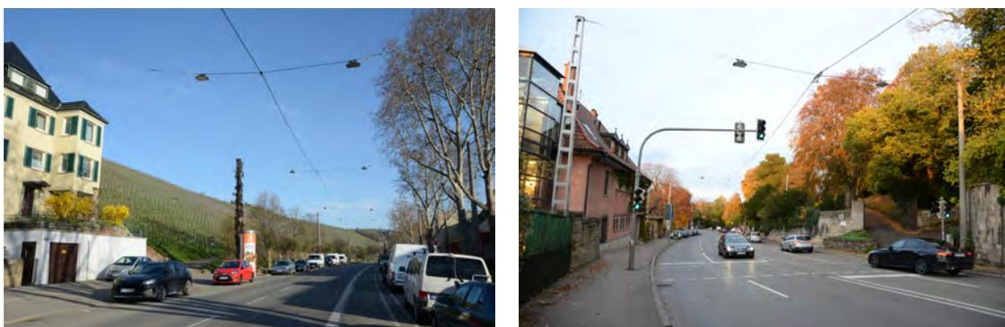
Abbildung 5.3: Augsburger Str. (links) Ausstattung der neuen Weinsteige mit modernen LED-Hängeleuchten vom Typ UrbanSky. Das Bild zeigt zugleich auch die 2019 sanierten Gittermasten. (rechts)
