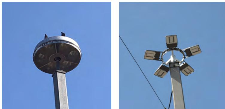
Abbildung 5.1: Berliner Platz: Altbestand (links) und neu entwickelte LED-Traverse (rechts)
