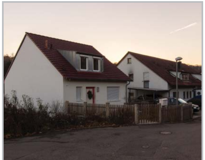
Feuerbach – Ein- und Zweifamilienhäuser der Baujahre ab Mitte 1990 (Foto: Matthias Strauß)
