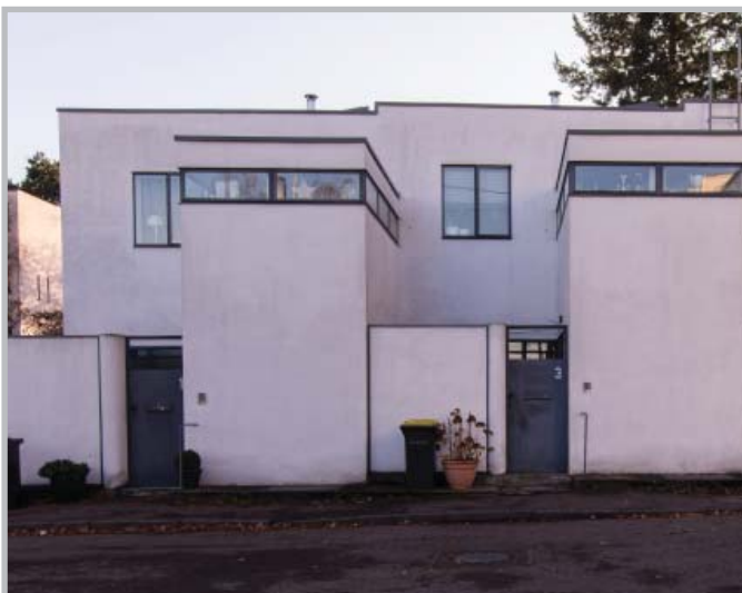
Reihenhäuser in der Weißenhofsiedlung, Baujahr 1927 (Foto: Matthias Strauß)
