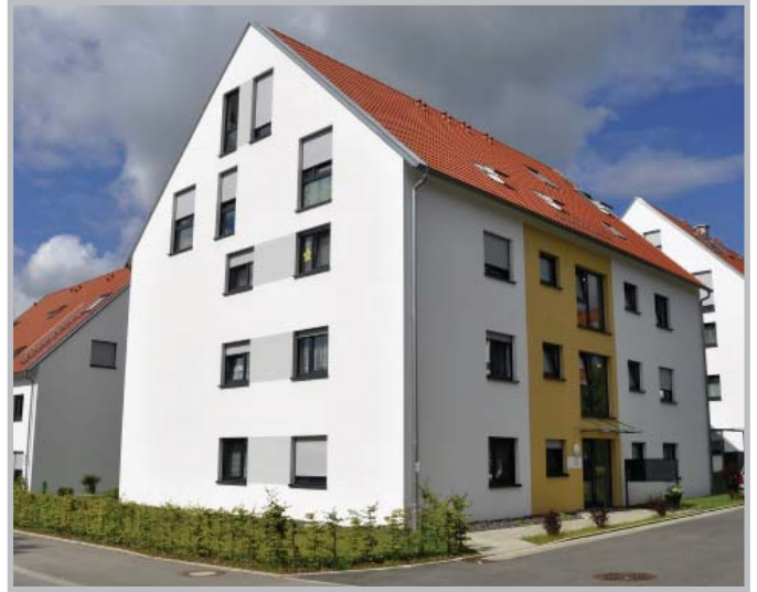
Geiger & Co – Sieben Morgen – Stammheim – 8 geförderte Wohneinheiten
