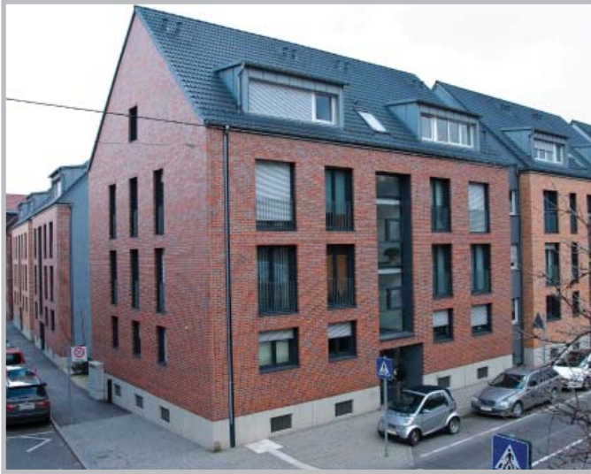
Bad Cannstatt – Mehrfamilienhäuser im Quartier Neckarvorstadt, Baujahr 2008 (Foto: Ansgar Schmitz-Veltin)
