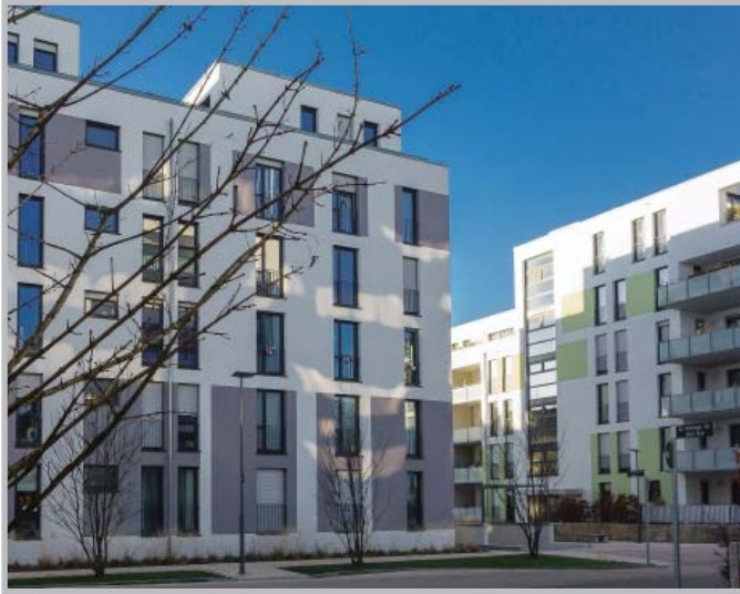
Möhringen – Seepark – rund 490 Wohnungen und angeschlossene Kindertagesstätte (Foto: Ansgar Schmitz-Veltin)
