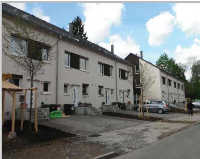
Activ Bau – Am Bergwald – Hedelfingen – 9 geförderte Wohneinheiten
