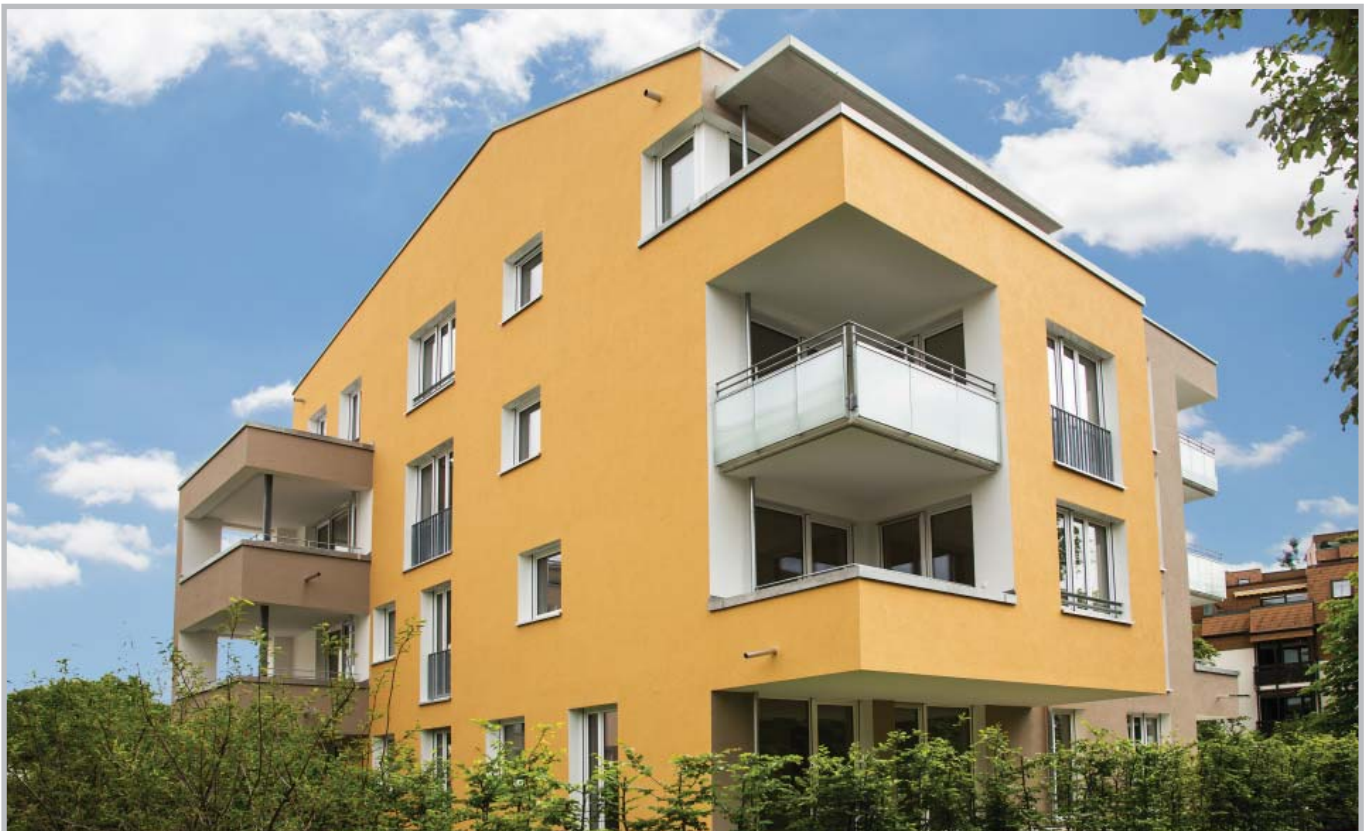
Siedlungswerk – Bernsteinstraße – Heumaden – 10 geförderte Wohneinheiten
