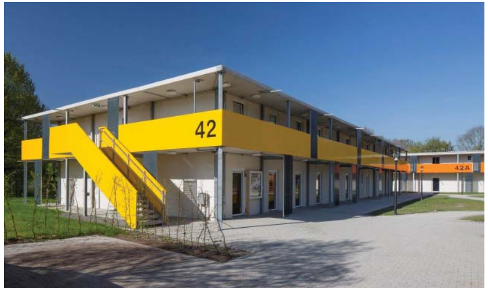
Flüchtlingsunterkunft in Systembauweise (Foto: SWSG/Friedemann Rieker)
