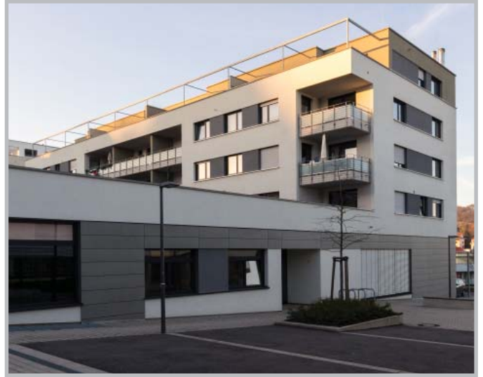
Feuerbacher Balkon – rund 180 Wohnungen: u.a. barrierefreie Mietwohnungen, Wohngruppen, Kindertagesstätte und Nahwärmenetz (Foto: Matthias Strauß)
