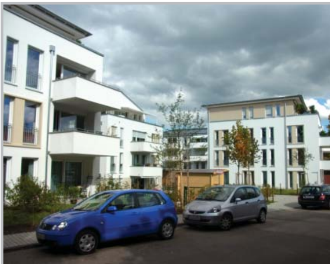
Heumaden – Neubau und Kernsanierung von rund 150 Wohnungen (Foto: Axel Fricke)
