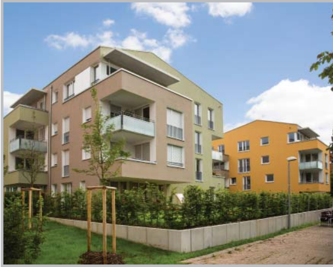
Siedlungswerk – Bernsteinstraße – Heumaden – 15 geförderte Wohneinheiten
