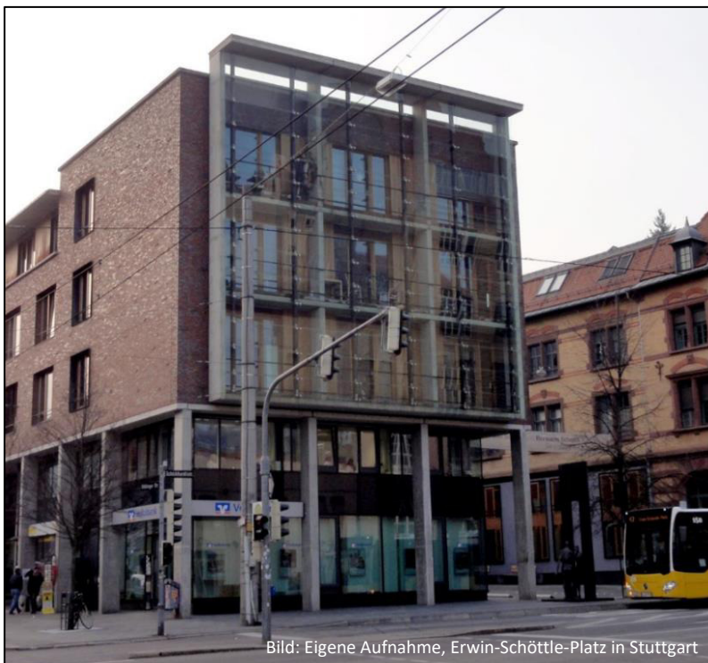
Abbildung 5 - Vorgehängte Glasfassade - Ausführungsbeispiel
