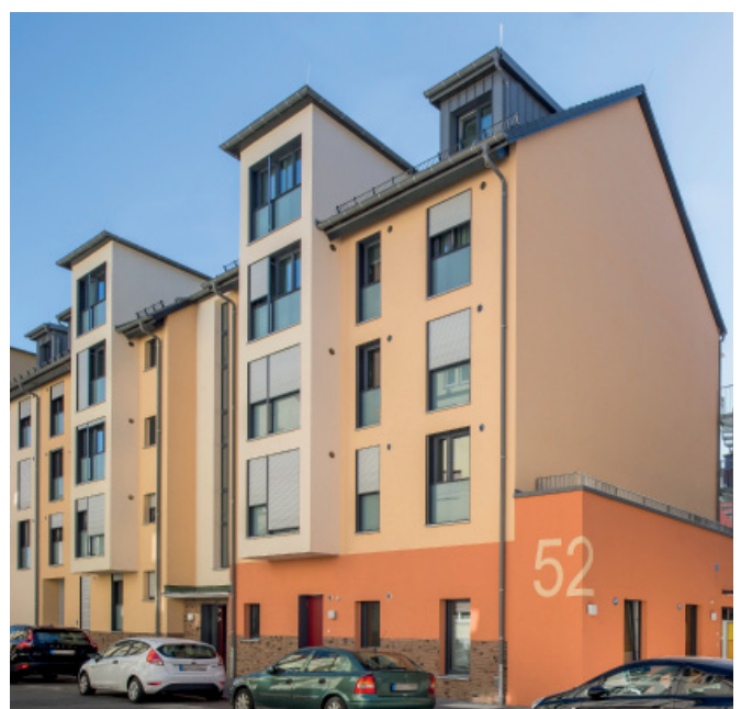
Bad Cannstatt – Neubau von 65 Mietwohnungen und einer Kindertagesstätte in der Reichenbachstraße, darunter 17 geförderte Wohnungen im Programm „Mietwohnungen für mittlere Einkommensbezieher“ (Foto: SWSG)
