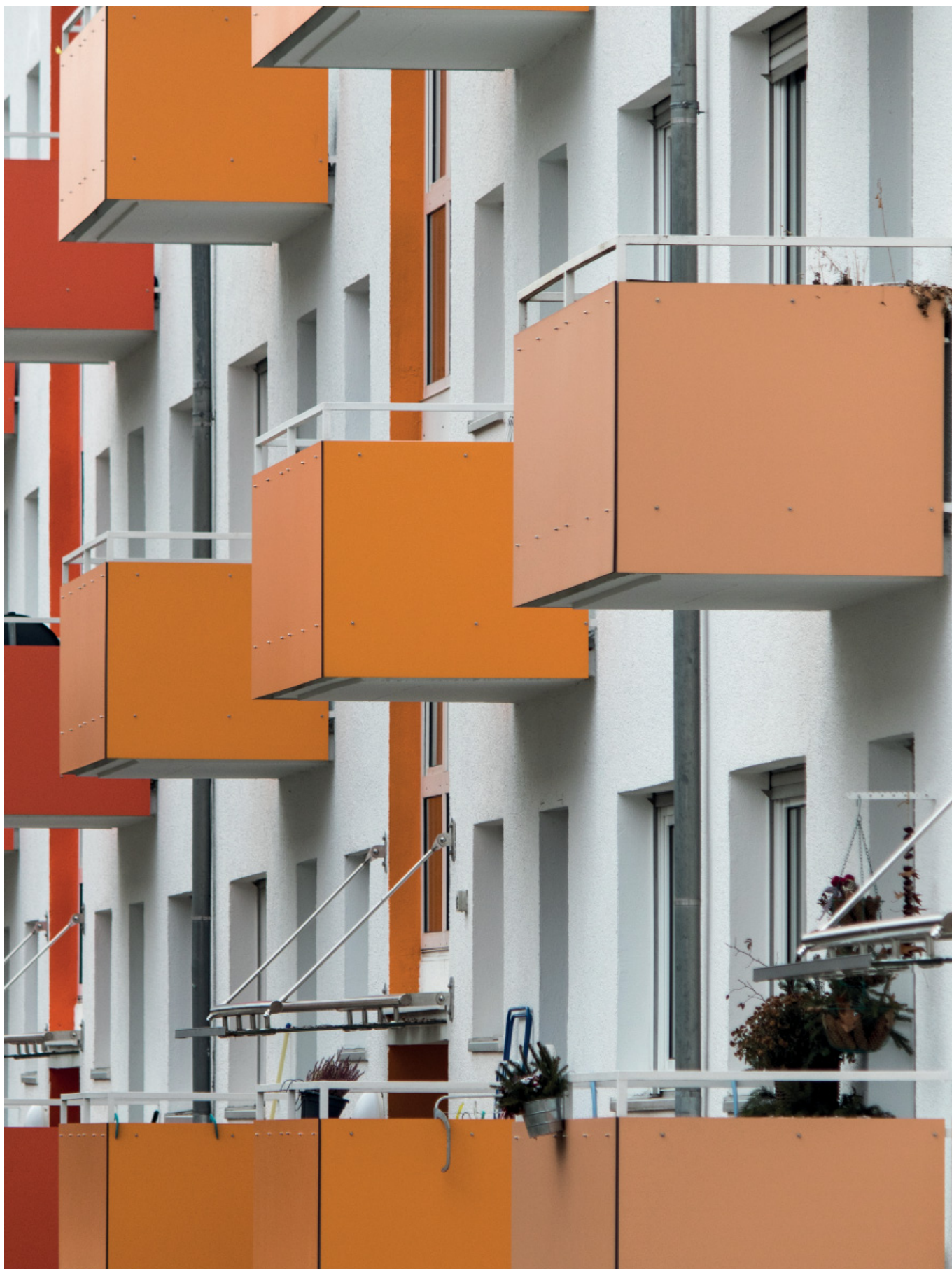
Fasanenhof – Modernisierungsmaßnahmen am Freytagweg (Foto: Matthias Strauß)
