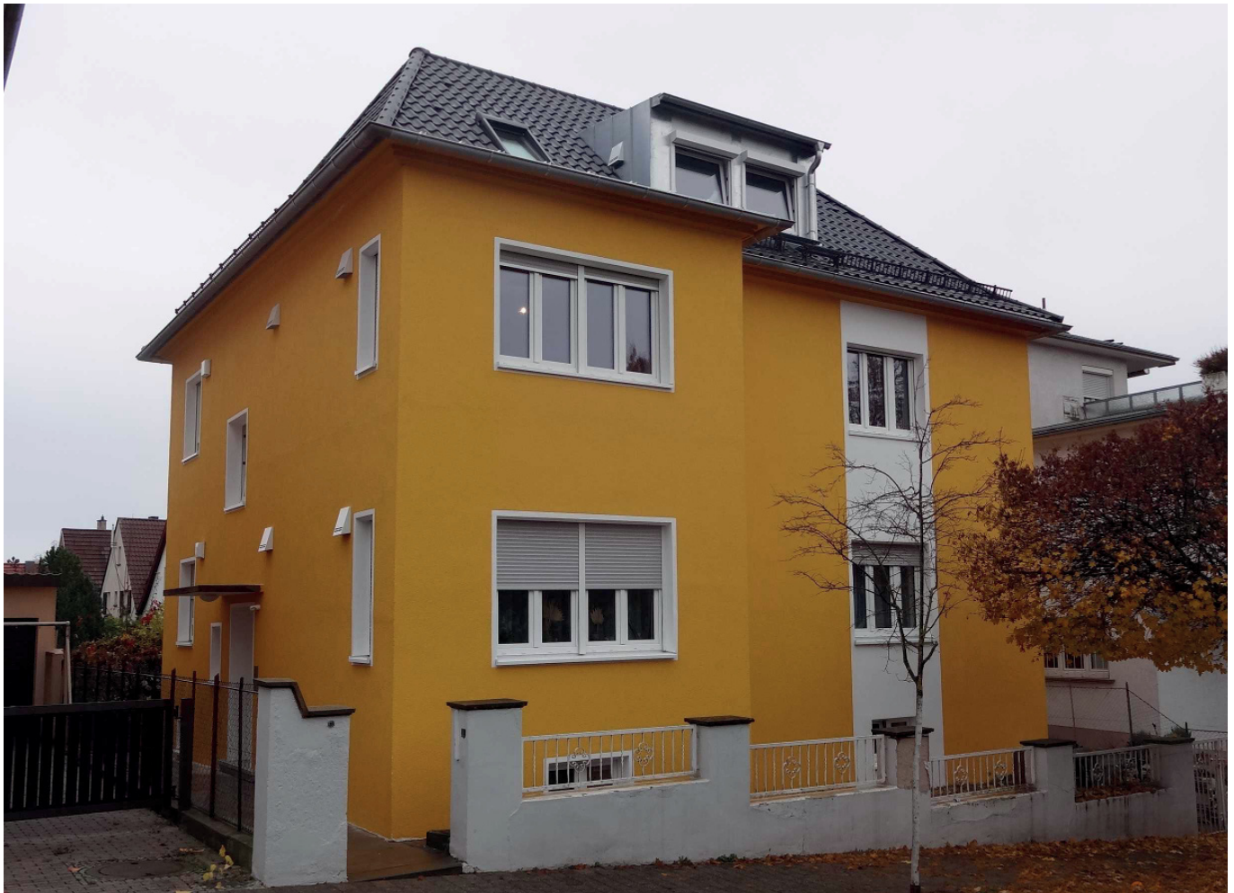
Wohnhaus in Feuerbach nach der energetischen Sanierung. Der Endenergiebedarf konnte um 94 % reduziert werden. (Foto: Ingenieurbüro für Energieberatung Gäbler)
