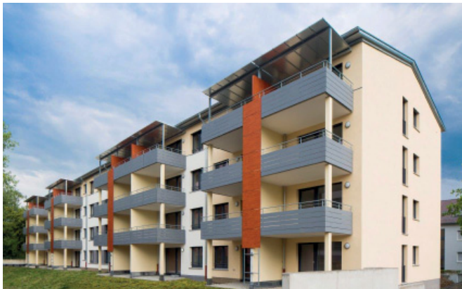
Ersatzneubau von 72 Mietwohnungen am Stichlingweg in Mühlhausen-Mönchfeld, darunter 24 Sozialmietwohnungen und 13 Mietwohnungen für mittlere Einkommensbezieher (Foto: SWSG)
