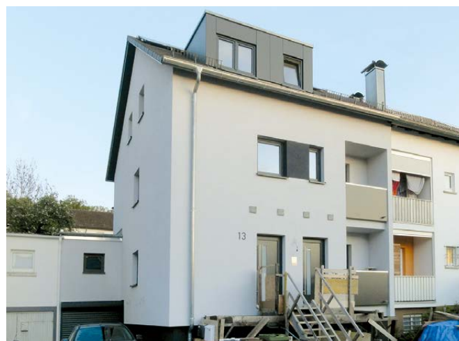
Wohnhaus in Stuttgart-Wolfbusch vor und nach der energetischen Sanierung. Der Endenergiebedarf konnte um 95 Prozent reduziert werden (Foto: Energieberatungszentrum Stuttgart e.V.).
