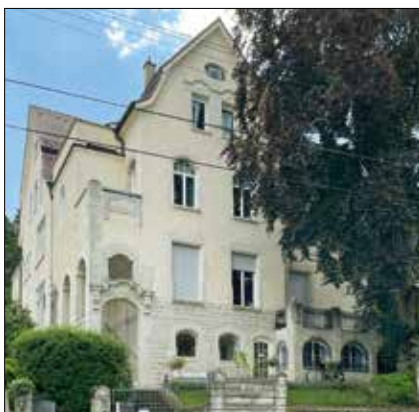
Gerokstraße 17, Stuttgart Ost
