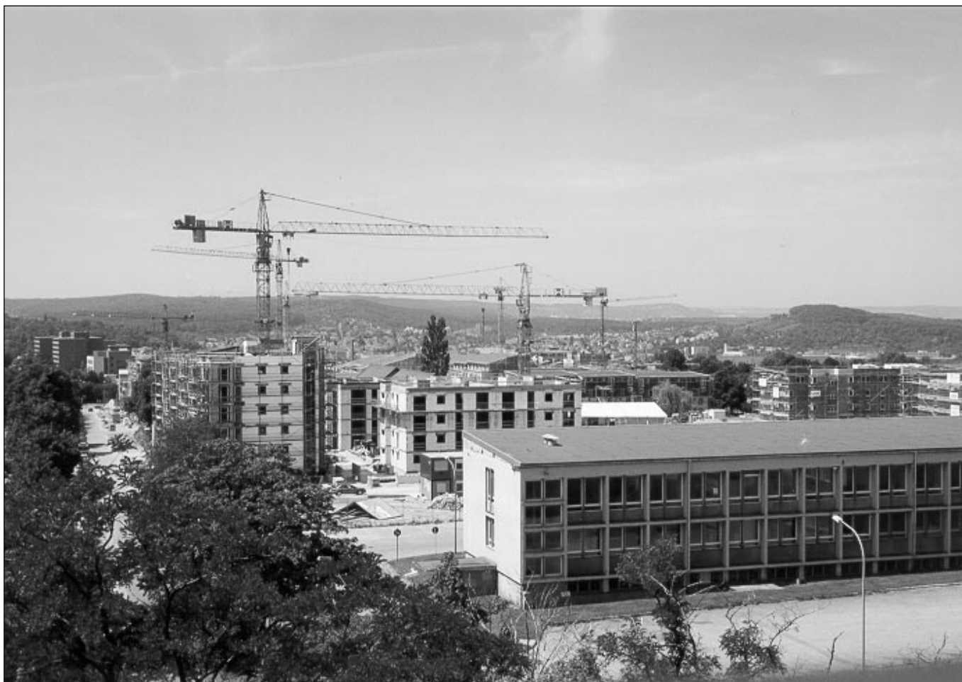
Bild: Auf dem ehemaligen Kasernengelände auf dem Burgholzhof entstehen derzeit rund 700 Wohnungen. Im Juli 1998 hat der Einzug der ersten Bewohner begonnen. (Bild: LEG)
