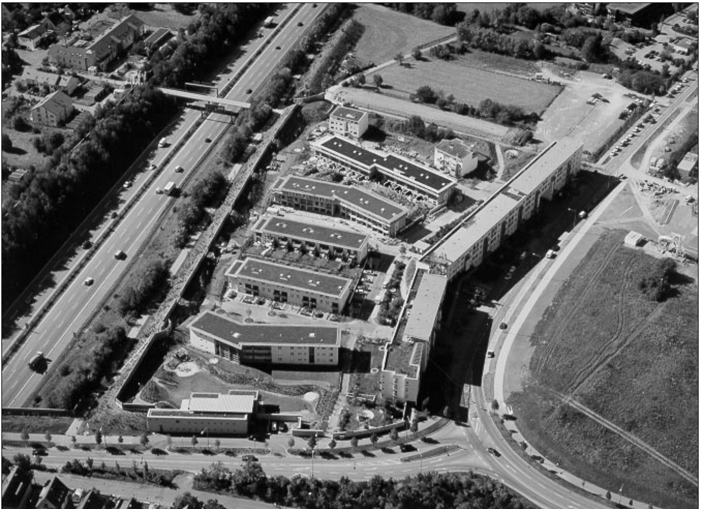
Bild: Luftaufnahme des Wohnquartiers Birkhof-Ost in Stuttgart-Vaihingen (Bild: LEG) Die Anlage mit 164 Wohneinheiten hat insgesamt vier Architekturpreise erhalten.
