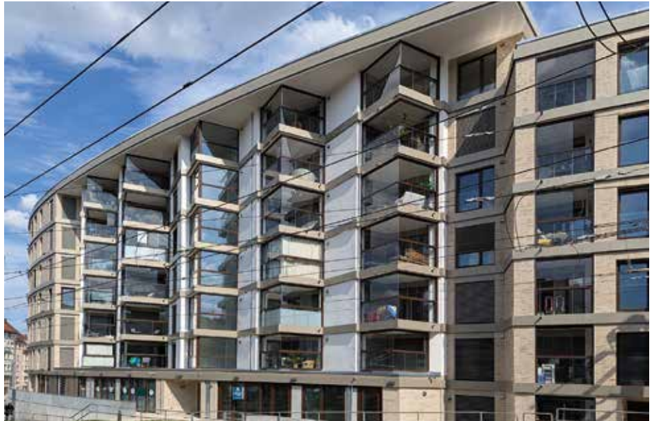
Das „Ensemble Am Vogelsang“ aus vier Punkthäusern und einer Ellipse in Stuttgart-West wurde 2023 fertiggestellt. Insgesamt sind 152 Wohnungen sowie sechs Gewerbeeinheiten entstanden. (Foto: Andrea Brenner und Laura Schmitt)
