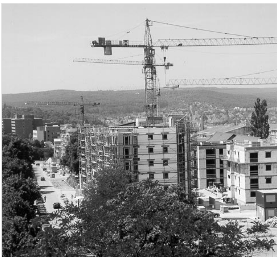
Bild 2: Auf dem ehemaligen Kasernengelände der US-Armee auf dem Burgholzhof (Stadtbezirk Bad Cannstatt) entstehen derzeit etwa 700 Wohnungen. Das Bild zeigt den Baufortschritt im Juni 1998; die ersten Wohnungen wurden im Juli 1998 bezogen. (Bild: LEG)
