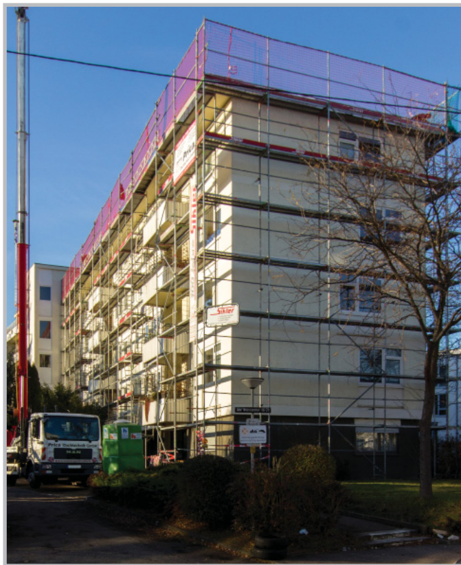
Sanierung in der Weißenhofsiedlung (Foto: Matthias Strauß)
