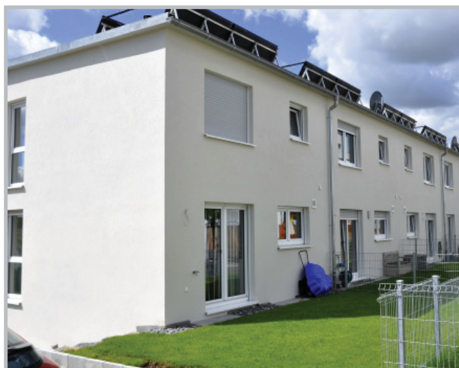
Geiger & Co – Bohnapfelweg – Zazenhausen – 12 geförderte Wohneinheiten
