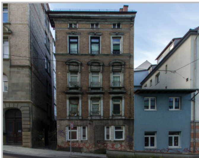
Wohngebäude mit Sanierungsbedarf (Foto: Matthias Strauß)
