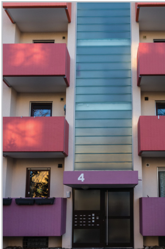
Saniertes Mehrfamilienhaus in Möhringen (Foto: Ansgar Schmitz-Veltin)
