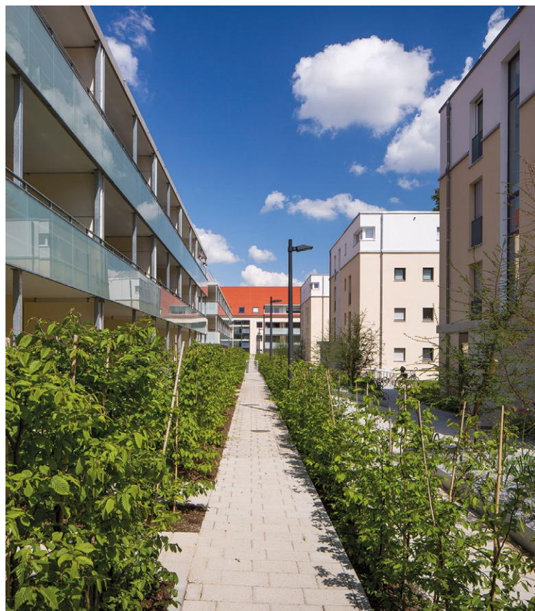
Wohnbebauung auf der Steig im Hallschlag: 109 neue Wohneinheiten in einem differenzierten Wohnungsgemeinde nach Abbruch von 81 Wohneinheiten (Foto: SWSG)
