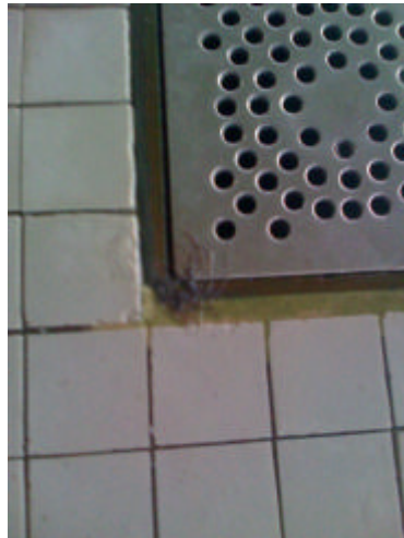
Abflussdeckel im Schwimmbadbereich
