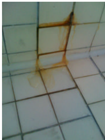
Boden im Bereich der Liegeflächen im Schwimmbadbereich
