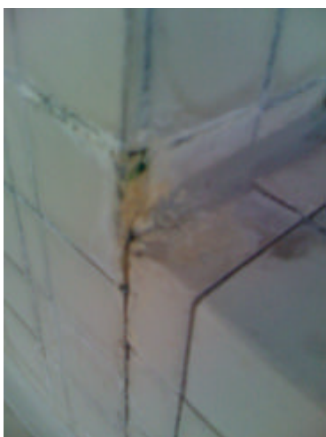
Boden im Bereich der Liegeflächen im Schwimmbadbereich
