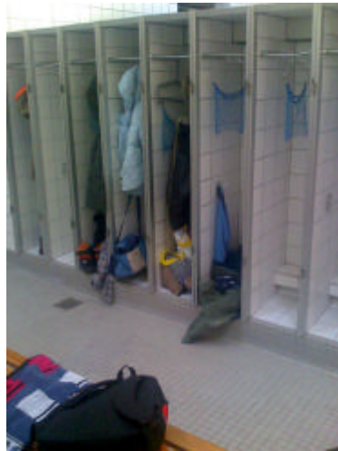
Umkleidebereich ohne Türen
