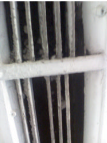
Lüftungsgitter im Bereich der Duschen bei den Jungen
