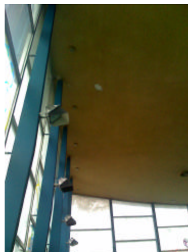
Dach des Hallenbades im Schwimmbeckenbereich
