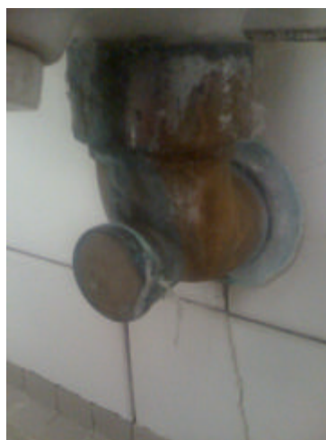
Abwasserrohr im Jungen WC
