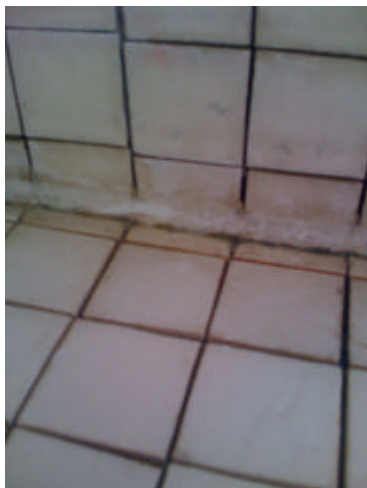
Boden im Bereich der Liegeflächen im Schwimmbadbereich
