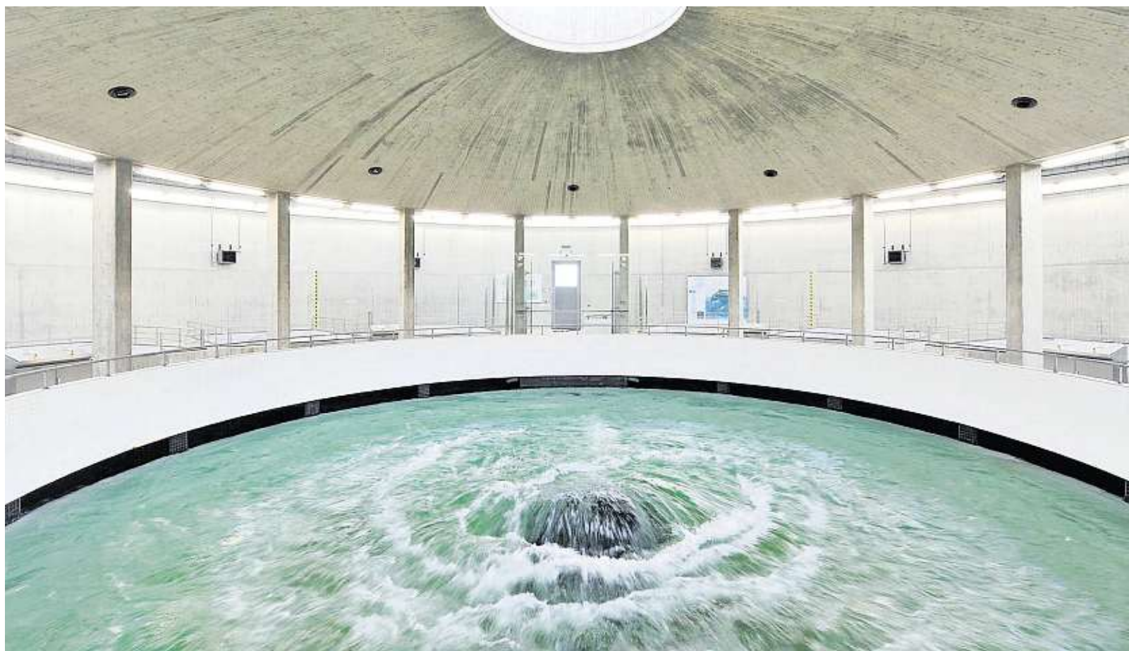
Das kühle Nass, das von der Bodenseewasserversorgung in Sipplingen gefördert wird, fließt unter anderem in die Landeshauptstadt. FOTO: DPA
