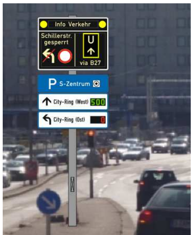
Parkleitschild mit Belegungsanzeige und dynamischer Anzeigetafel
