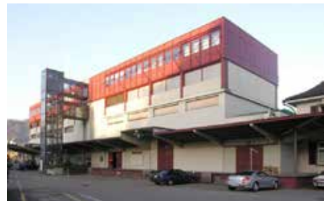
Abb. 118: Ehemaliges Bahnhofsgebäude nach der Aufstockung, Quelle: burkhalter sumi architekten
