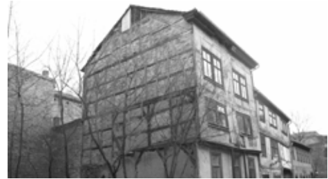
Abb. 76: Bestandsgebäude vor der Sanierung, Quelle: Märkplan GmbH
