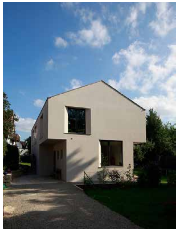
Abb. 101: Giebelfassade, Quelle: Palais Mai Architekten
