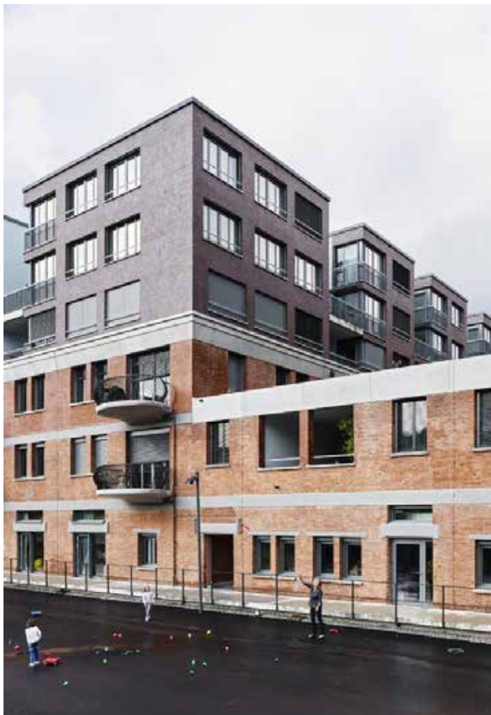
Abb. 85: Aufstockung der ehemaligen Lagerhalle, Quelle: Georg Aerni
