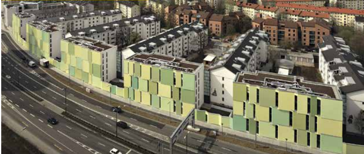
Abb. 90: Anbauten an bestehende Zeilenbauten, Quelle: Léonwohlhage Architekten
