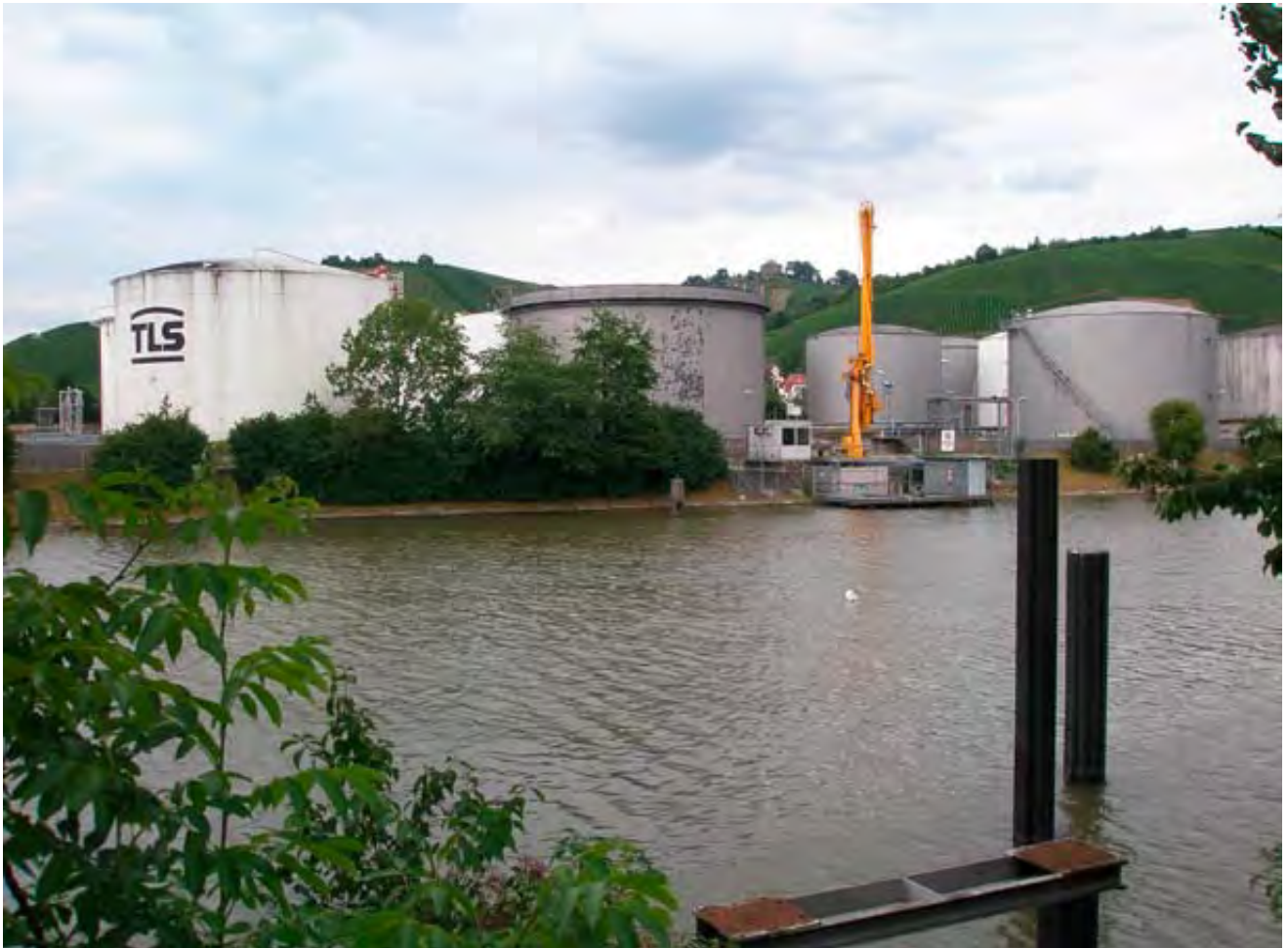
Tanklager am Ölhafen, Hafen Stuttgart, Stuttgart-Untertürkheim
