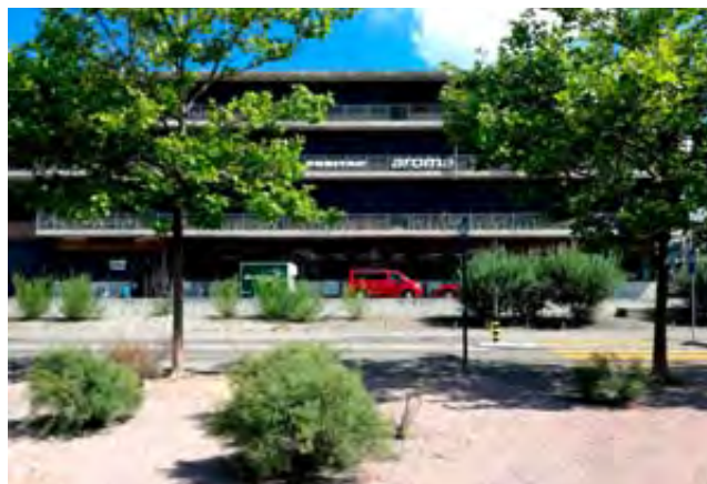
Gewerbehaus NOERD, Binzmühlestrasse, Zürich-Oerlikon
