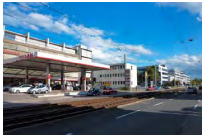
Gewerbequartier Wangen Nord, Stuttgart-Wangen
